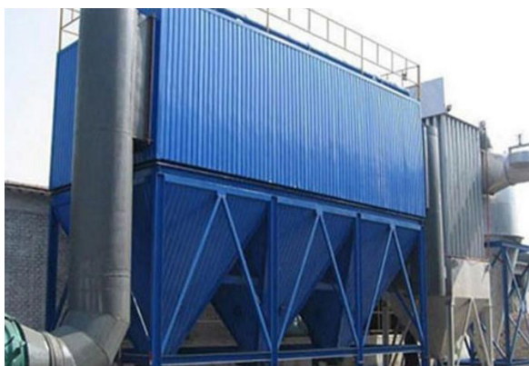
Figura 3 - Precipitador eletrostático industrial.
