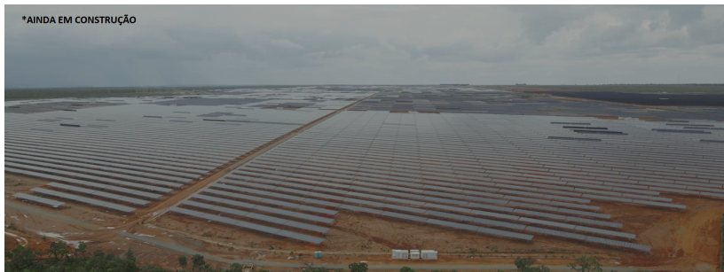
Figura 3 – Maior usina de energia solar em atividade na América Latina.
