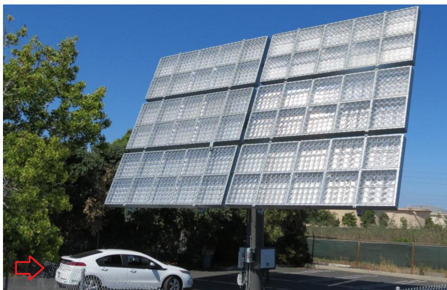
Figura 4 – Comparativo de tamanho, módulo CPV e um carro.
