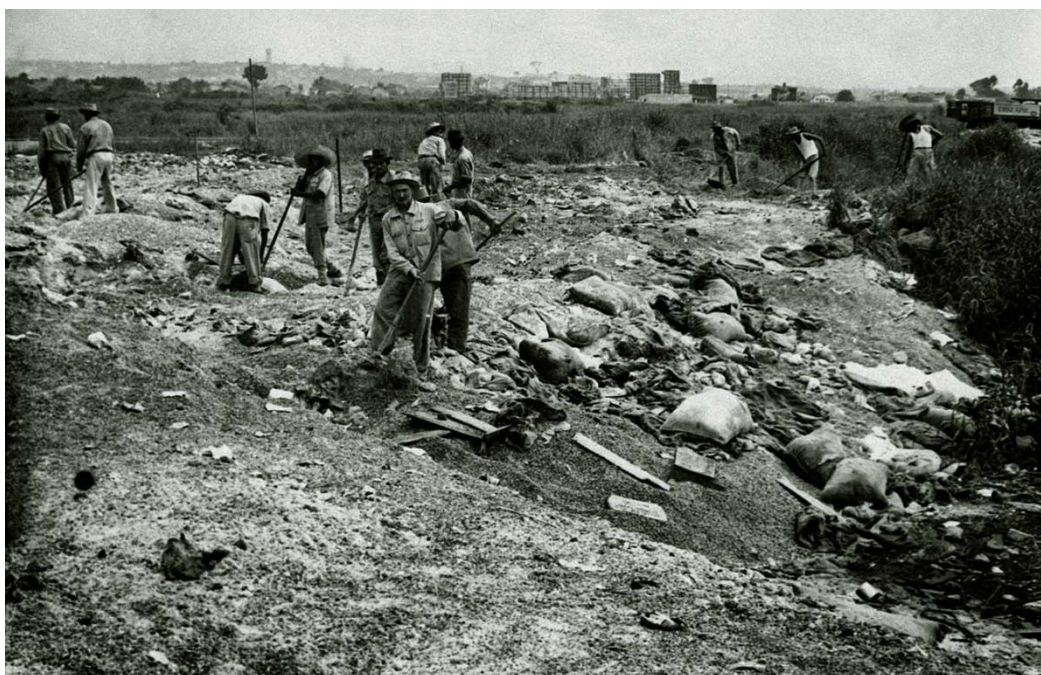
Figura 5- Depósitos a céu aberto, conhecidos como lixões.
