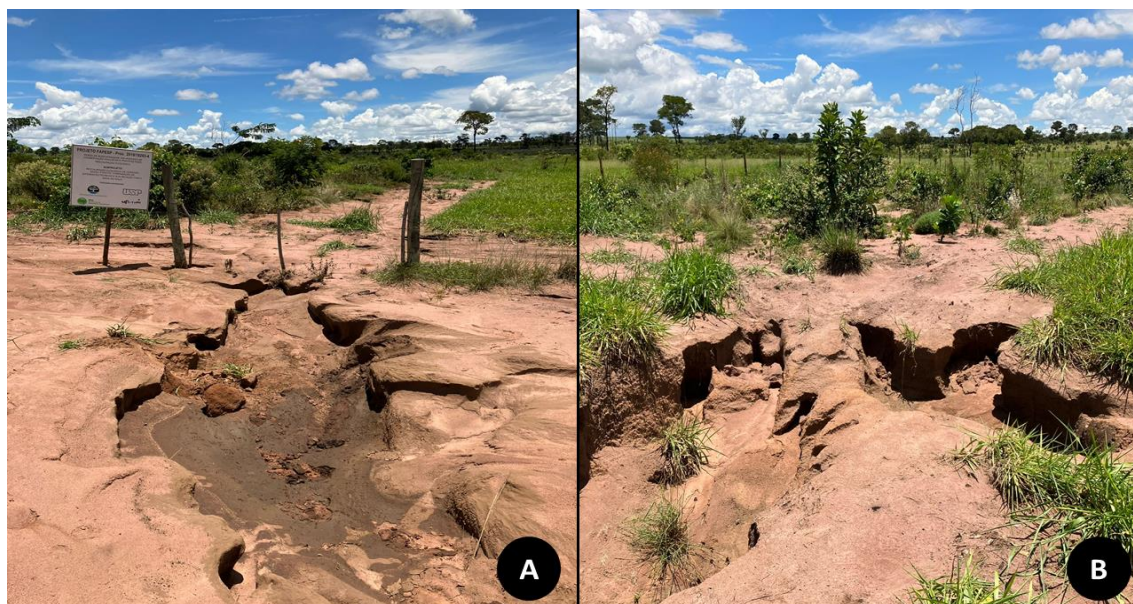
Figura 36. Foco de erosão e carreamento de sedimentos nos limites do experimento (A); e outro ponto de erosão no interior da área experimental (B), EExSS, São Simão, SP. Data das imagens: jan./2023.
