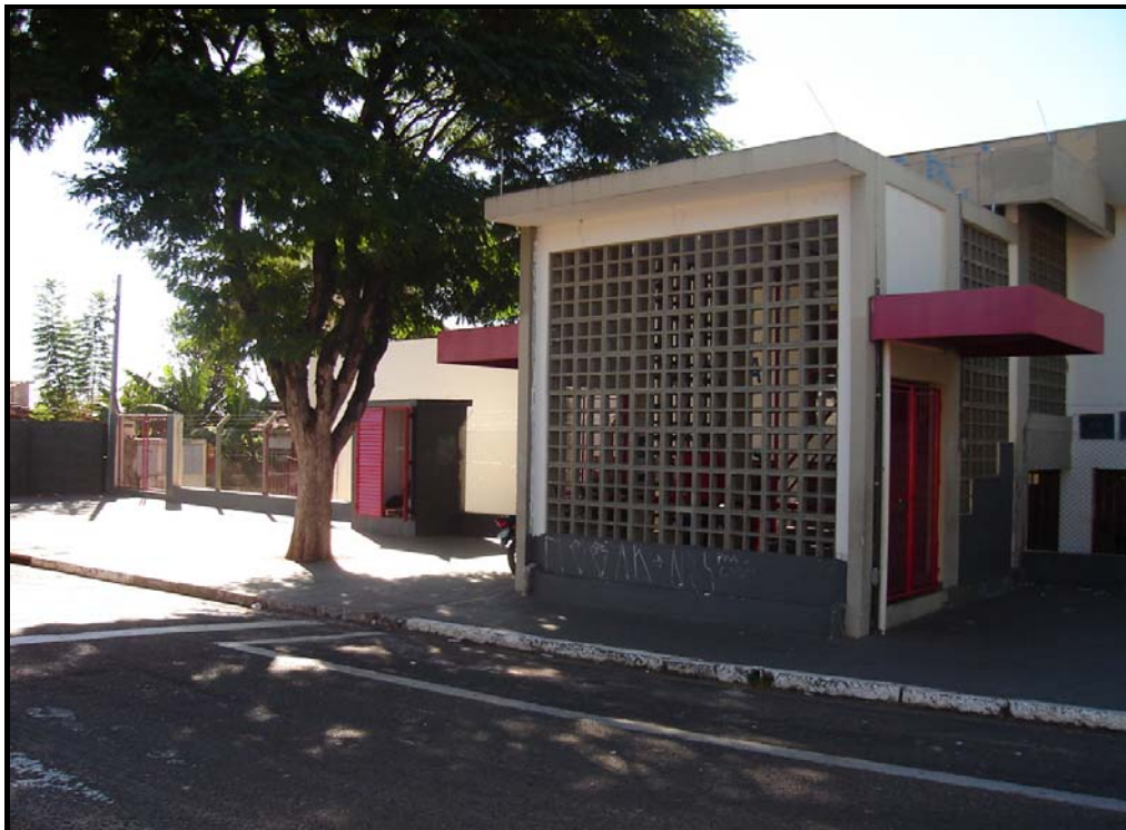
Figura 3: Fachada da Escola Alfa.
