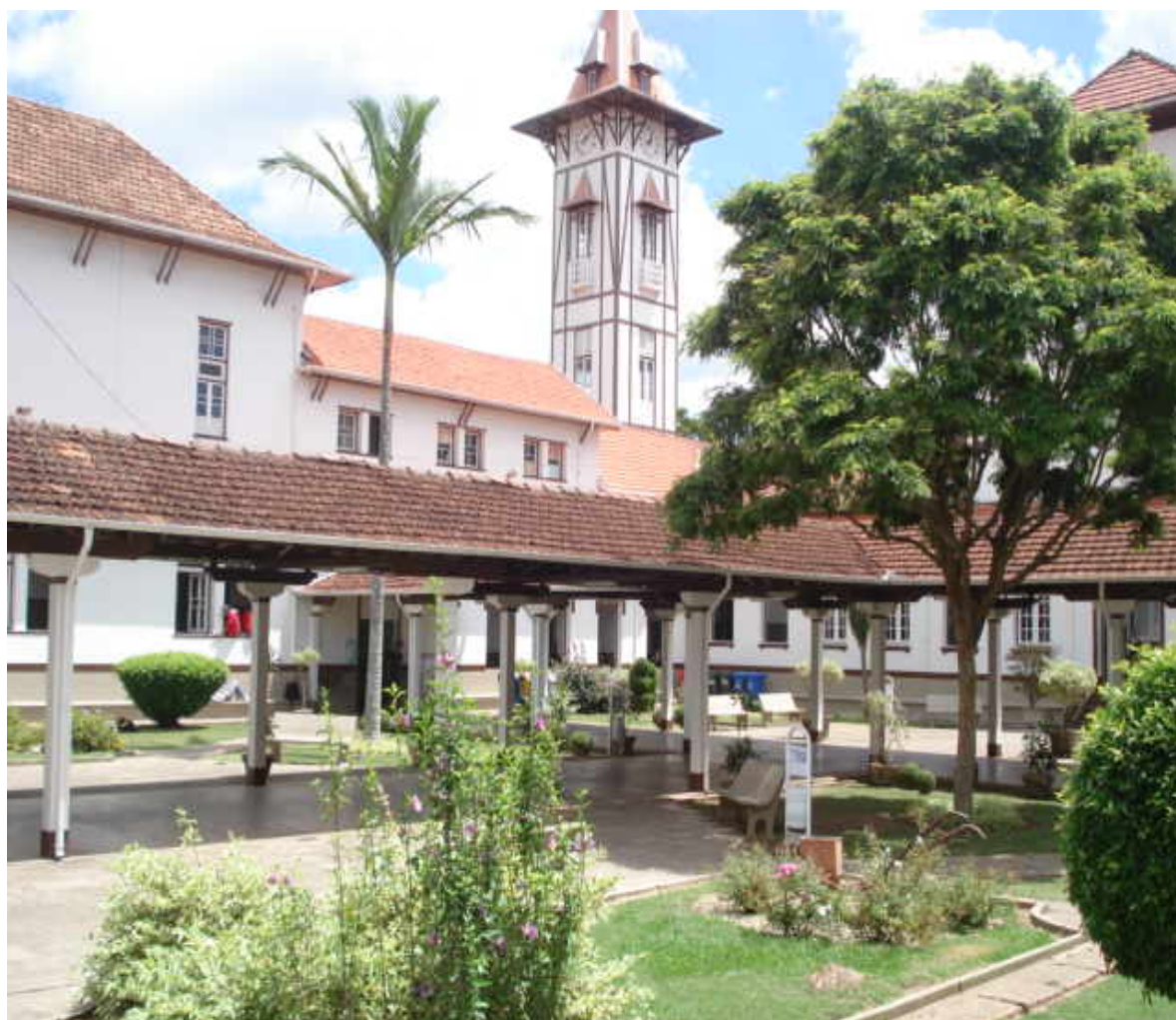
Figura 7 – Vista do pátio central do prédio principal do IFSudestemg / Campus Barbacena – Outubro de 2010
