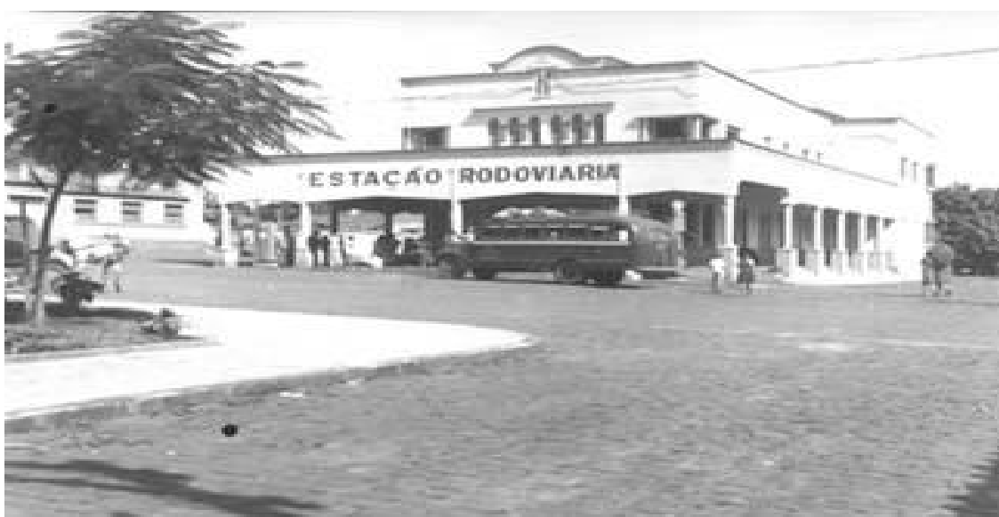
Figura 39 - Estação Rodoviária de Uberlândia-MG / década dos anos 1950
