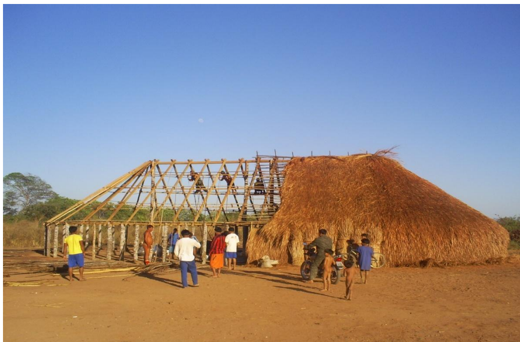
Figura 22: Cobertura das casas feita na época da seca
