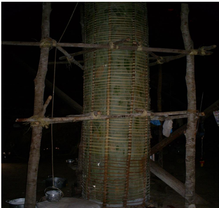
Figura 26: silo para o armazenamento de polvilho de mandioca
