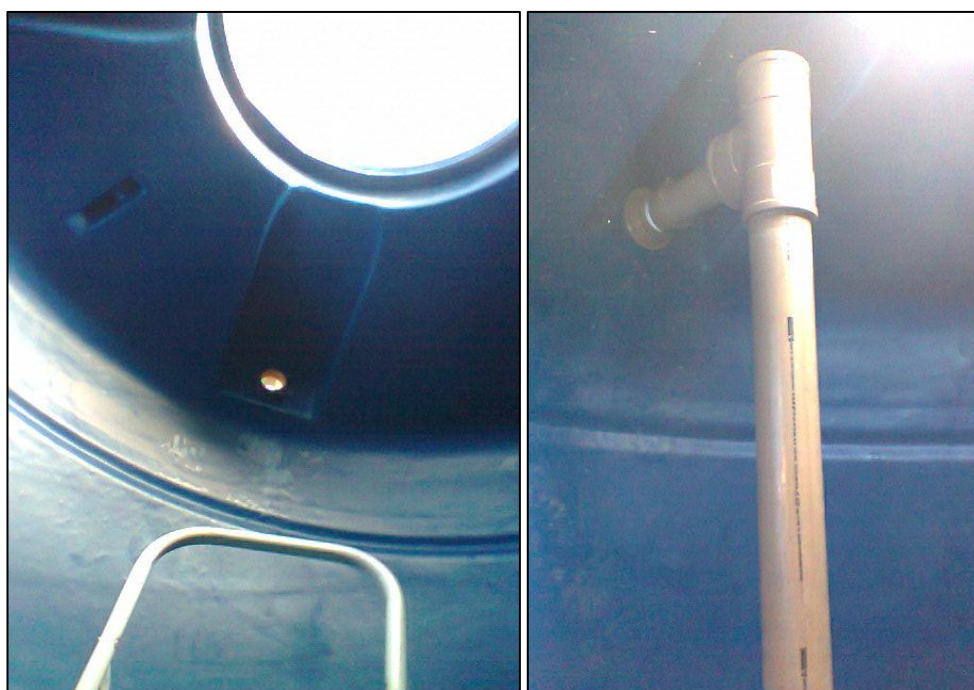
Figura 5. Interior do tanque séptico, antes e depois a instalação do tubo para coleta do efluente líquido
