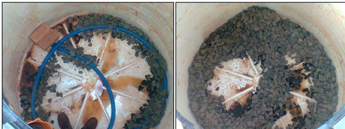
Figura 6. Interior do filtro anaeróbio de fluxo ascendente. Na esquerda, a mangueira instalada e depois seu preenchimento com brita nº 4
