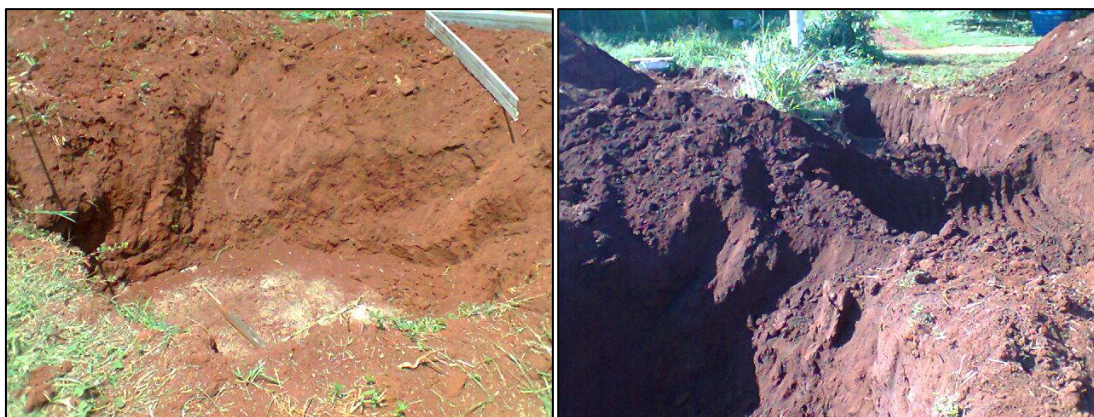
Figura 2. Cavidades escavadas para inserção dos tanques
