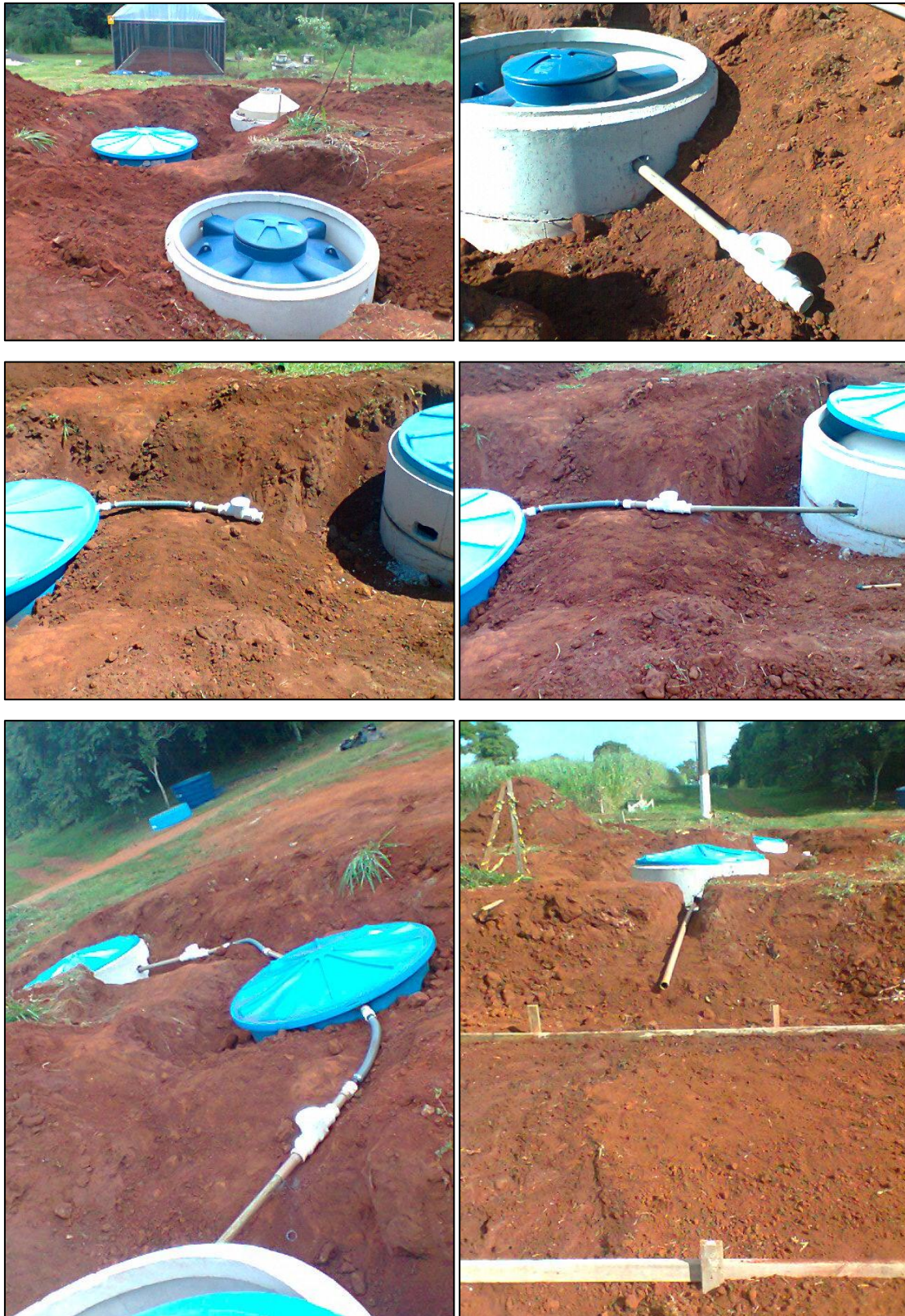
Figura 7. Imagens da construção das conexões da estação
