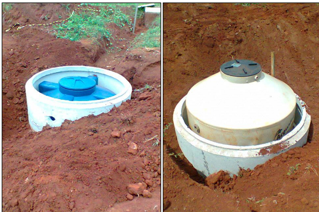
Figura 4. Tanques envoltos nas anilhas de concreto
