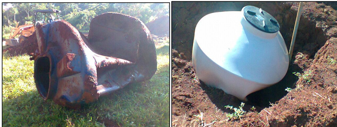
Figura 3. Tanques danificados após o soterramento
