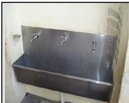
FOTO 01 – Escola A – Bebedouro
