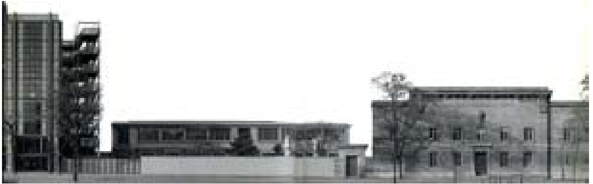
Figura 07 - Fachada da Escola Especial de Arquitetura - ESA
