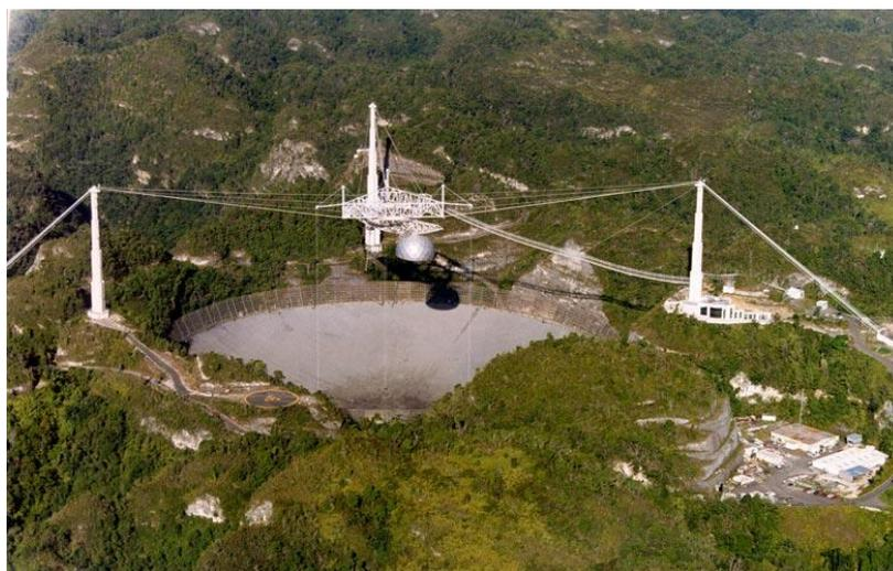
(b) Arecibo, o maior radiotelescópio de uma única antena com diâmetro de 305 m.
