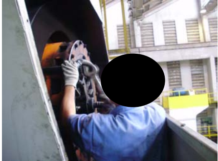
Foto 1: Profissionais soltando tubulação pneumática.
