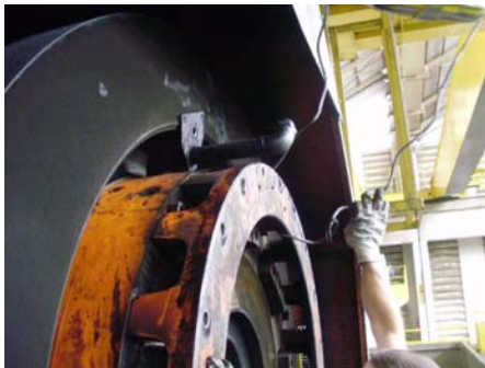
Foto 4: Profissional verificando a tensão correta de esticamento do cabo de aço.
