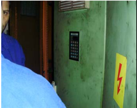
Foto 4: eletricitas verificando parâmetros do conversor do motor
