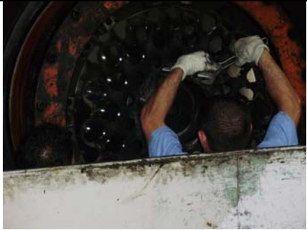
Fotos 2 e 3: Profissionais apertando os tirantes para destacar o porta elementos
