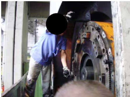
Foto 5: Profissionais movimentando volante para içamento (vertical)
