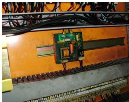
Foto 6: encontrada causa da falha (resistor da placa de controle de campo)
