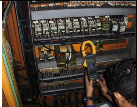
Foto 3: eletricitista medindo a corrente de campo com alicate amperímetro
