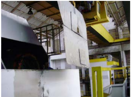
Foto 5: Proteção suspensa e transportada para a base da máquina.
