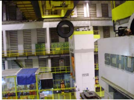
Foto 3: Retirada e transporte da tampa até a base da máquina
