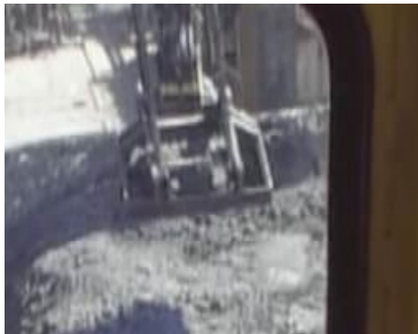
Caçamba cheia sendo movimentada para o estoque intermediário
