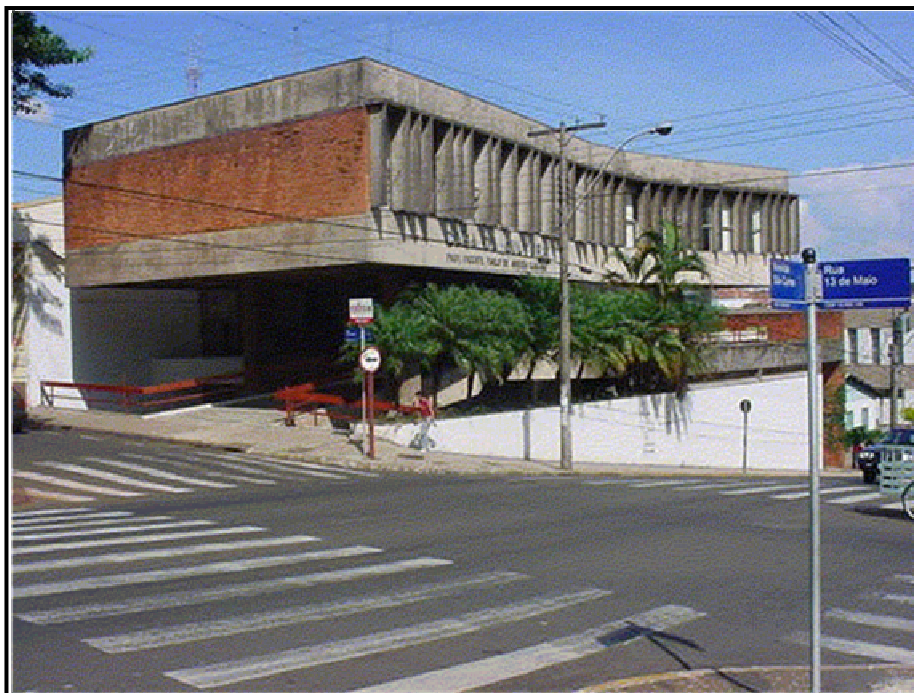
Figura 3.1. Vista da Biblioteca Municipal Amadeu Amaral.
