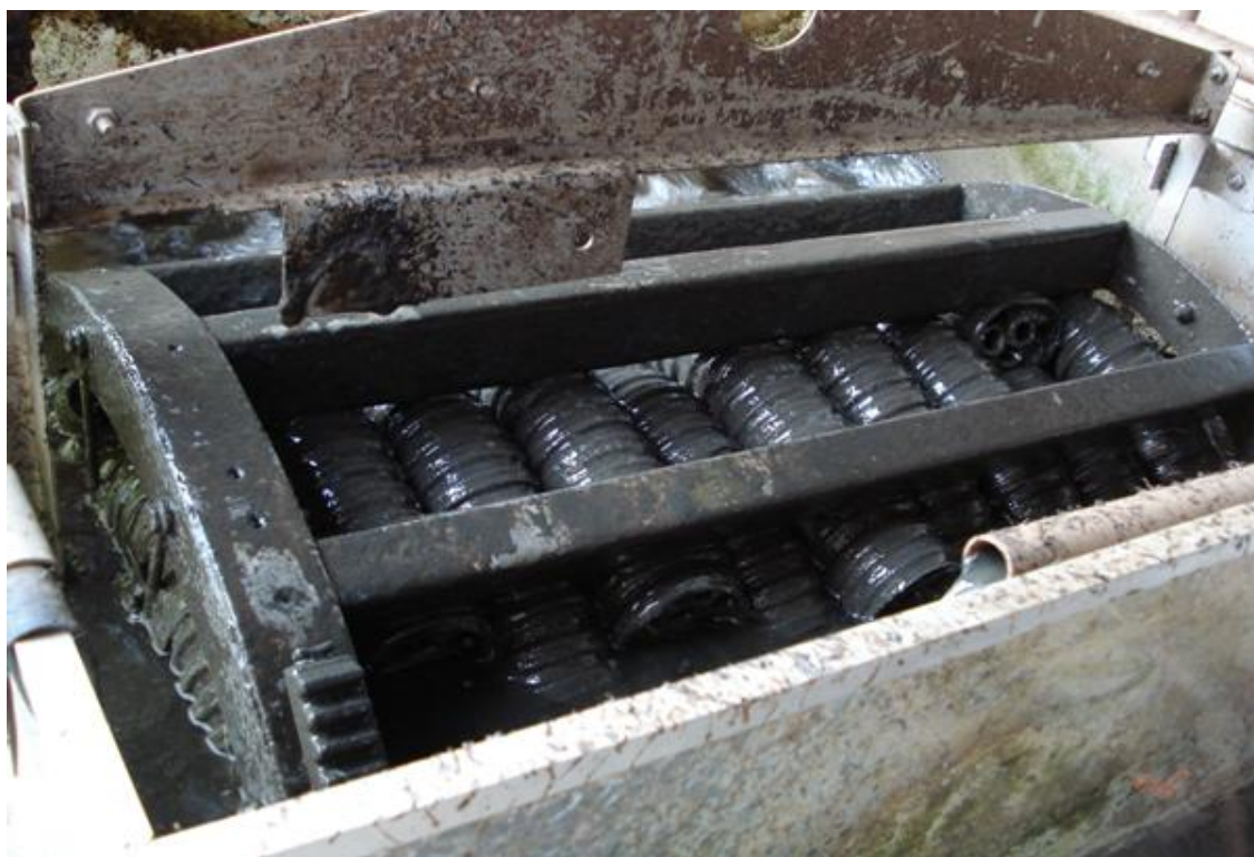
Figura 5.15: RBC após 7 meses de operação, com destaque para o biofilme formado.
