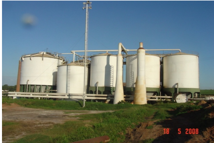
Figura 2.2. Foto de algumas das dornas de fermentação de uma unidade industrial no Estado de São Paulo.
