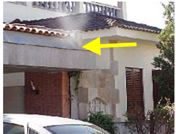
Figura 5.2 – Identificação da Ligação Clandestina
