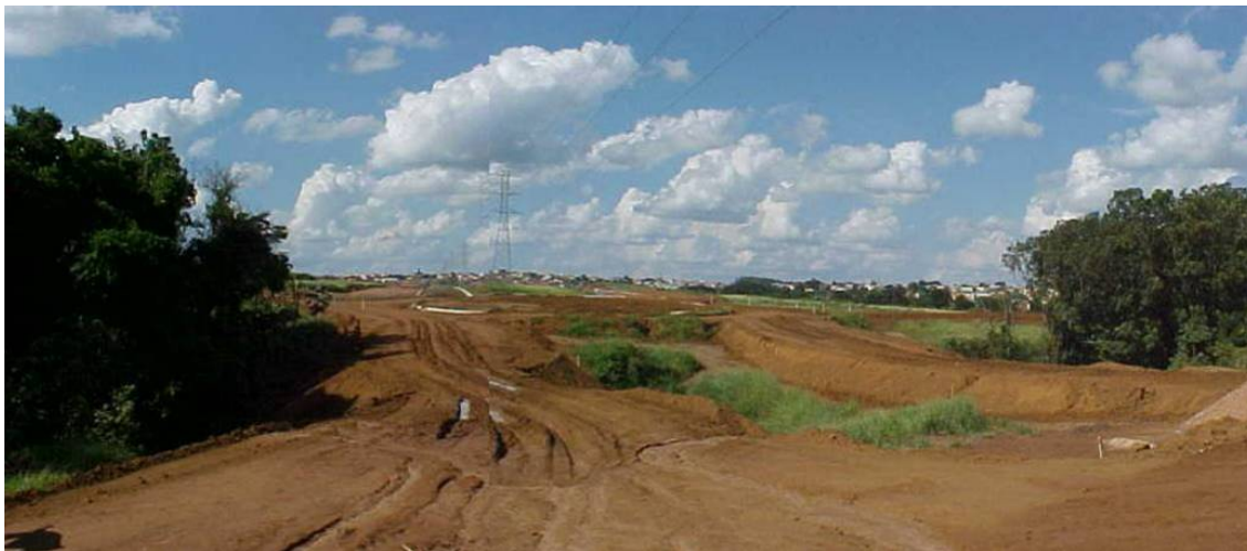
Foto 62: Ruas do campus II da USP em construção – pequeno trecho do córrego tamponado sob as vias – modificação da topografia da área (02/2004).
