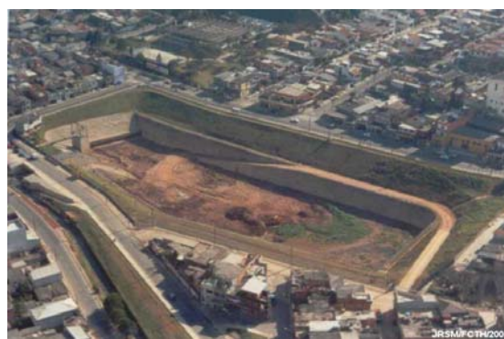
Foto 28: Ocupação de fundo de vale por áreas de retenção de águas pluviais, “piscinão” ( curso d’água retificado ). Área metropolitana de São Paulo-SP
