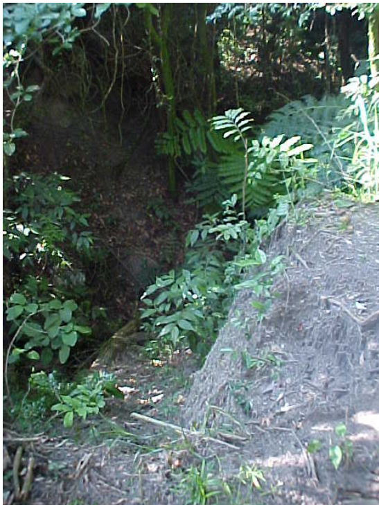
Foto 66: Aspecto do córrego em outro segmento do Trecho 5 - erosão decorrente do acesso de pessoas à margem (02/2004).
