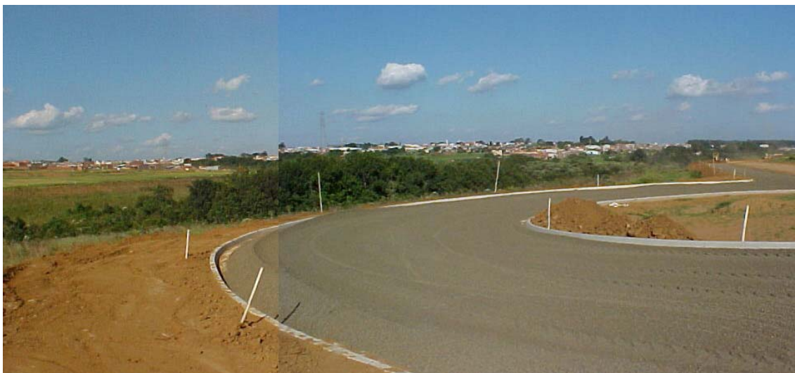
Foto 86: Rua em construção no campus II da USP e mata ciliar ao córrego ao fundo (03/2004).
