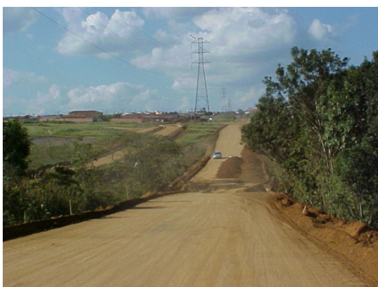
Foto 71: Ruas em construção no campus II da USP – trecho tamponado do córrego sob a via (03/2004).
