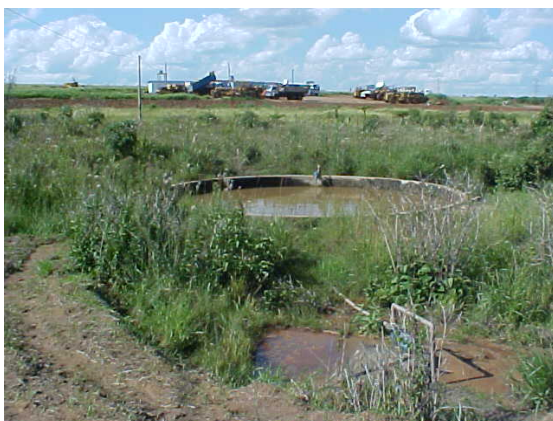
Foto 63: Pequeno reservatório de água na nascente do córrego do Mineirinho e maquinário das obras ao fundo (02/2004).
