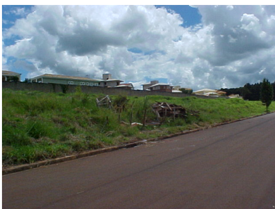
Foto 41: Rua Passeio das Magnólias e muro do Residencial Parque Faber I ao fundo (03/2004).
