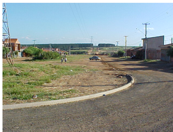
Foto 88: Loteamento Social Santa Angelina e rua que dará acesso ao campus II da USP (03/2004).
