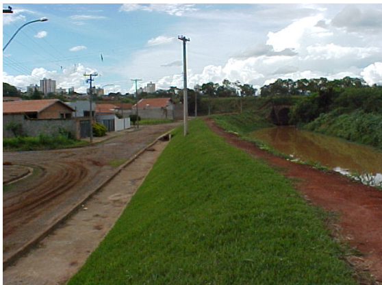
Foto 07: Ocupação de fundo de vale por rua e loteamento ( curso d'água não modificado ). Rio Piracicamirim, Piracicaba-SP
