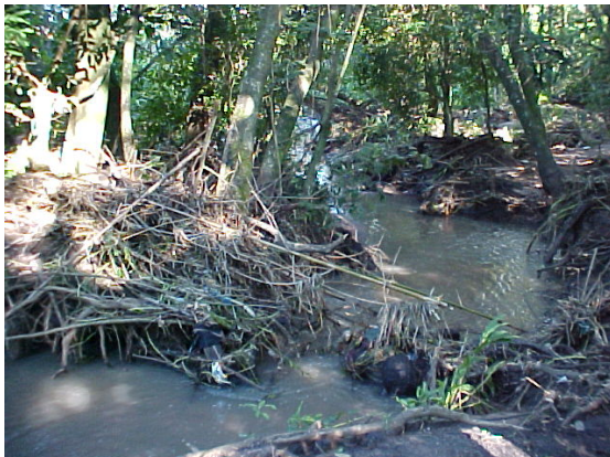
Foto 54: Aspecto do córrego no Trecho - presença de sedimentos obstruindo o canal devido a inundações (02/2004).
