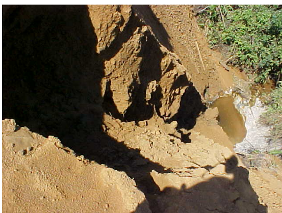
Foto 64: Aspecto do córrego junto à ponte – erosão decorrente das obras (02/2004).
