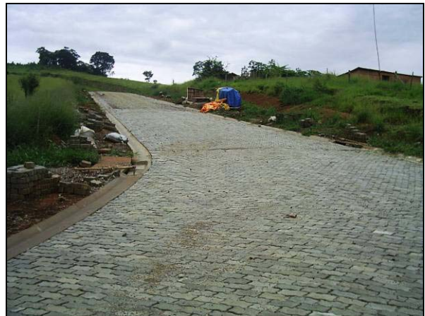
Figuras 58 e 59: Transição entre o piso de blocos articulados e piso com cascalho recém construídos (Fotos do autor).
