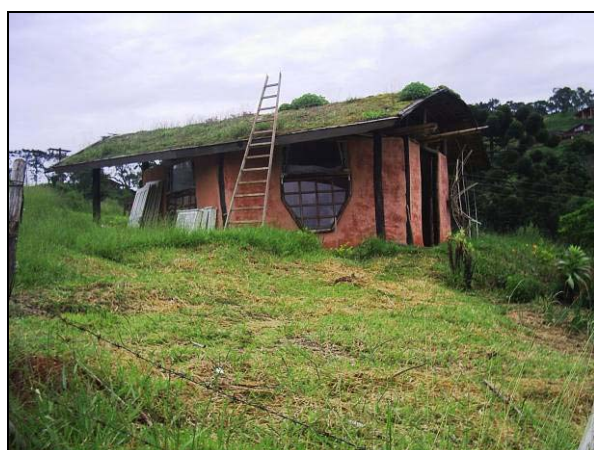
Figuras 66 e 67: Uma edificação local em cuja construção foi utilizada taipa com matérias de reutilizados e telhado verde (Fotos do autor).
