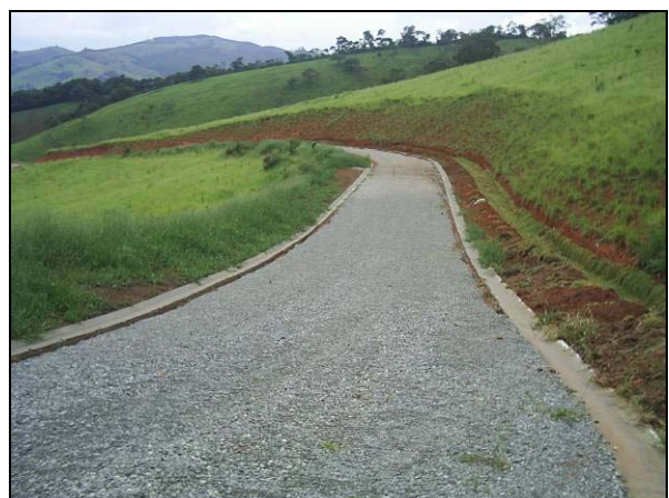
Figuras 60 e 61: Detalhe da canaleta de concreto pré-moldado para coletas de águas pluviais em “V” e detalhe do corte do talude e via recém construídos (Fotos do autor).
