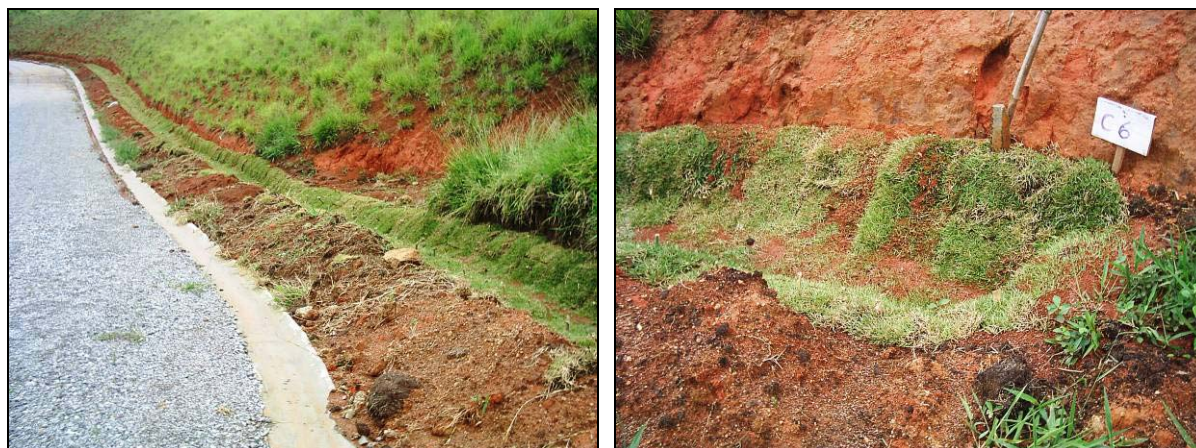
Figura 62 e 63: detalhe da canaleta de concreto e da canaleta gramada para retenção de águas pluviais e solo recém construídas (Fotos do autor).
