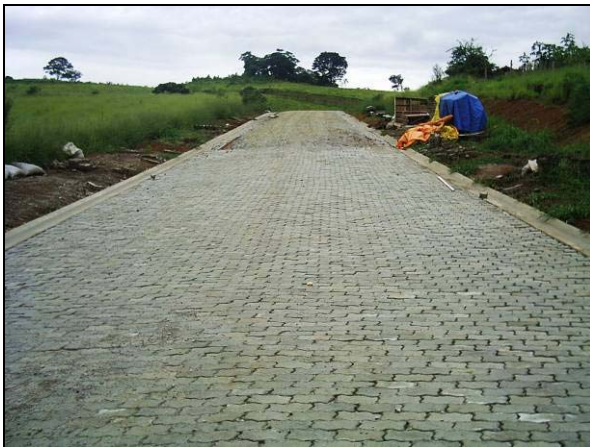
Figuras 58 e 59: Transição entre o piso de blocos articulados e piso com cascalho recém construídos (Fotos do autor).
