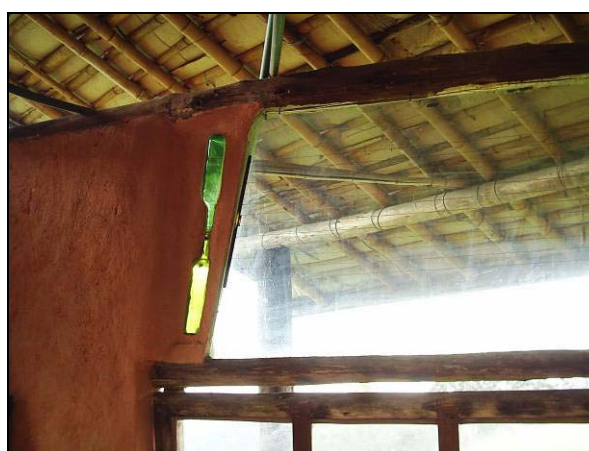
Figuras 68 e 69: A estrutura de suporte do telhado é feita com bambu com a forração de papelão e sacos plásticos reutilizados e detalhe da estrutura e dos materiais reutilizados na construção (Fotos do autor).
