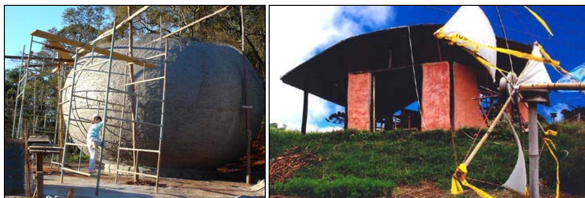
Figuras 44 e 45: Caixa d'água de ferro-cimento e Construção do local.(fonte: CLAREANDO, 2006).
