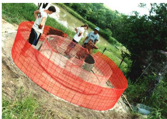
Figuras 75 e 76: construção do Biofiltro hidropônico na Ecovila Visão futuro de Porangába-S.P. (fonte: FRANCISCANDO, 2006).
