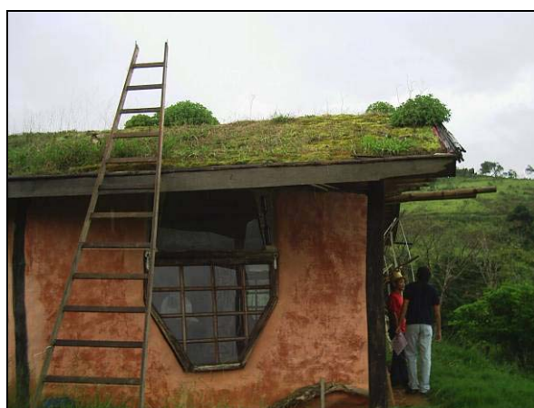
Figuras 66 e 67: Uma edificação local em cuja construção foi utilizada taipa com matérias de reutilizados e telhado verde (Fotos do autor).
