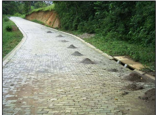
Figuras 56 e 57: Entrada da Ecovila com piso intervalado que atravessa a APP e detalhe da “Boca-de-lobo” recém construída (Fotos do autor).
