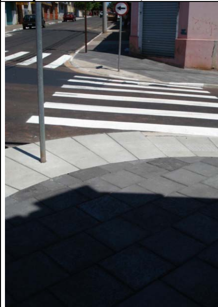
Figura 6.13: Travessia da Rua Riachuelo (trecho 2)
