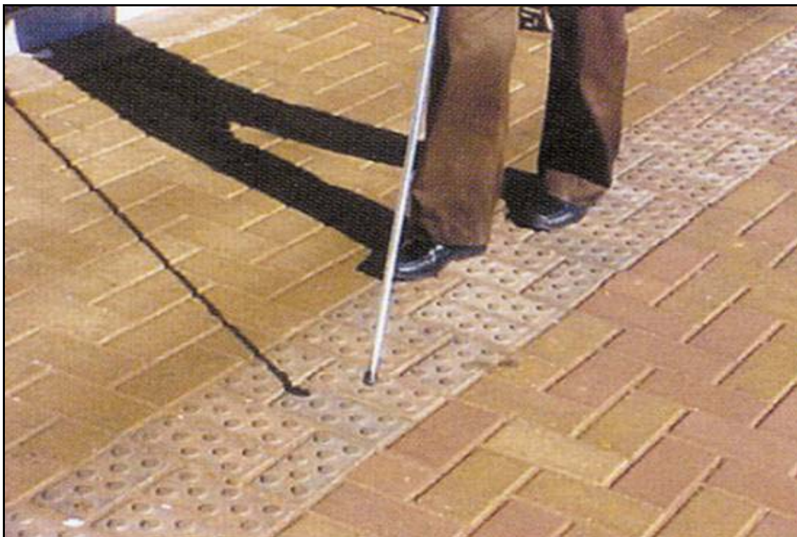
Figura 4.1: Calçada com marcação podotáctil
