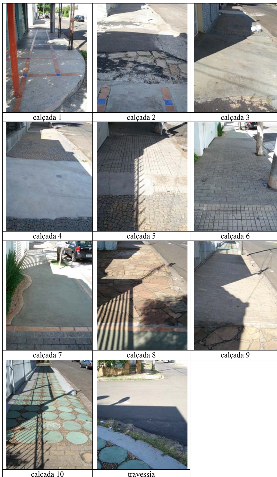
Figura 6.14 – Calçadas e travessia do trecho 1: Rua 28 de Setembro
