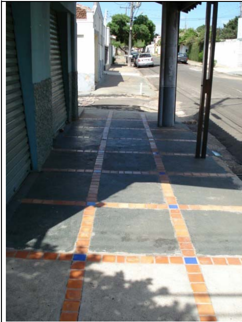
Figura 6.10: Calçada da Rua Vinte e Oito de Setembro (trecho 1)
