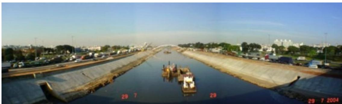
Figura 17 - Obras de aprofundamento, desassoreamento e limpeza da calha do rio Tietê. Ago/2004 (Disponível em: <<http://www.dae.sp.gov.br/calha/index.htm>>. Acesso em: 25 ago. 2006).
