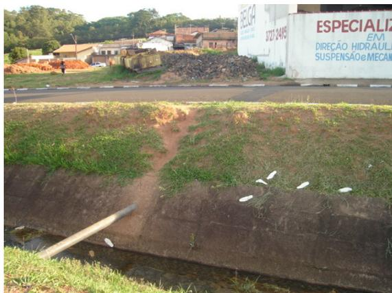
Figura 49 - Tubulação de esgoto funcionando como passarela, depósito de entulhos de construção e lixo queimado (Fotografia: Bruna da Cunha Felício. Set/2006).
