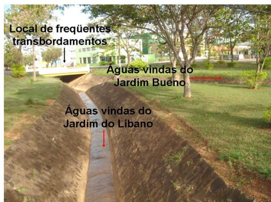
Figura 114 – Detalhe do local de união das águas vindas dos jardins do Líbano e Bueno (Fotografia e elaboração: Bruna da Cunha Felício. Out/2006).
