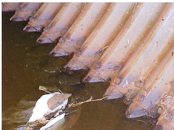
Figura 57 - Detalhe do estado de corrosão no fundo do tubo corrugado (GODOI, 2002).
