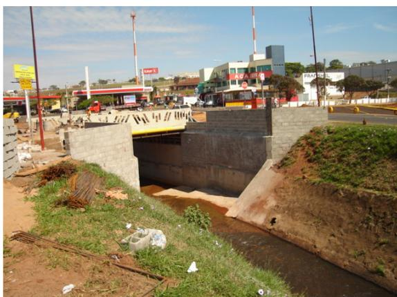
Figura 93 - Seção retangular, após o alargamento (Fotografia: Bruna da Cunha Felício. Out/2006).
