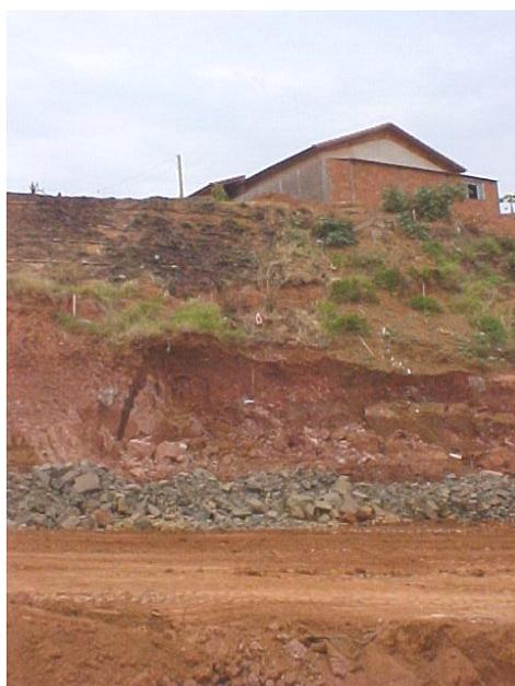
Figura 100 - Instabilidade de talude coloca em risco residência próxima, 1999 (GODOI, 2002).
