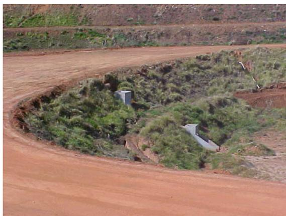
Figura 103 - Escorregamentos generalizados nos taludes, 2002 (GODOI, 2002).
