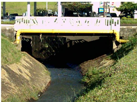
Figura 91 - Vista do canal do córrego do Cubatão que foi alargado, aqui ainda em seção trapezoidal (Fotografia: acervo fotográfico da PMF. Jul/06).
