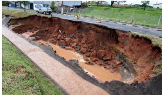
Figura 66 - Com a força das águas a erosão em frente à garagem da empresa de ônibus Cristalense foi agravada (Fotografia: Divaldo Moreira. Dez/2006).
