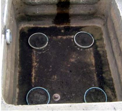
Figura 26 – Detalhe das trincheiras de infiltração, no fundo da caixa correspondente à um dos microrreservatórios de retenção. Acervo do autor.
