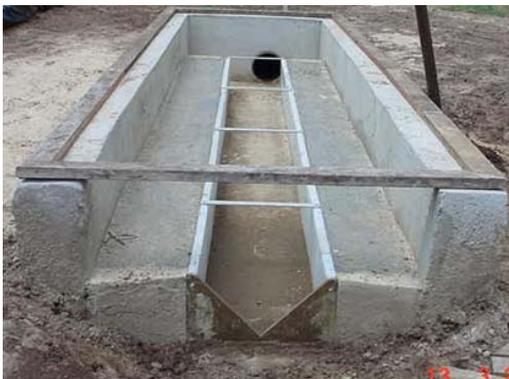
Figura 29 – Detalhe da calha e do vertedor. Acervo do autor.
