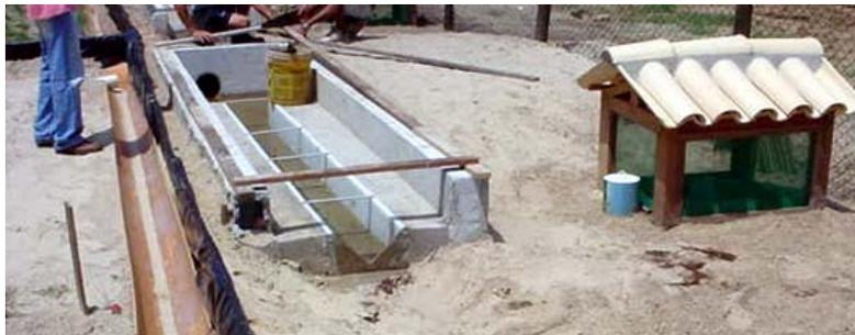
Figura 27 – Lote sustentável: detalhe da coleta das águas superficiais (esquerda), da calha e verterdor (centro), além do medidor (direita). Acervo do autor.
