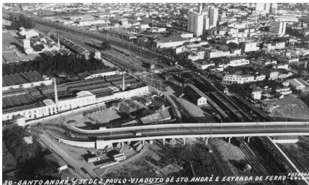
Figura 13 – obra viária da década de 1970 (Souza, 2000).
