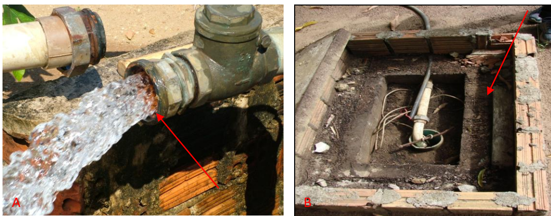
Figura 21 – (A) Poço tubular apresentando manchas de ferrugem nos canos (PT-09); (B) Poço tubular sem proteção sanitária (PT-07). Fonte: Marcio Silva.
