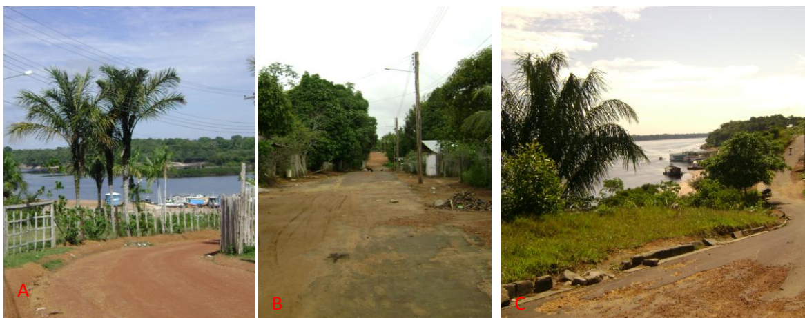
Figura 31 – (A) Via de terra (Bairro N. S. Auxiliadora); (B) Via mista (Bairro Anavilhanas); (C) Via asfaltada com meio-fio e sarjeta em condições precárias (Bairro Centro). Fonte: Sarita de Moura.
