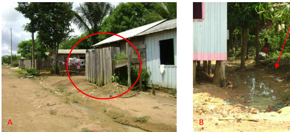
Figura 25 – (A) Residência com banheiro do lado de fora e água sendo escoada para a rua (bairro Santo Elias); (B) Residência com o escoamento do esgoto doméstico ao lado da casa, formando poças de águas paradas (bairro Santo Elias). Fonte: Sarita de Moura.
