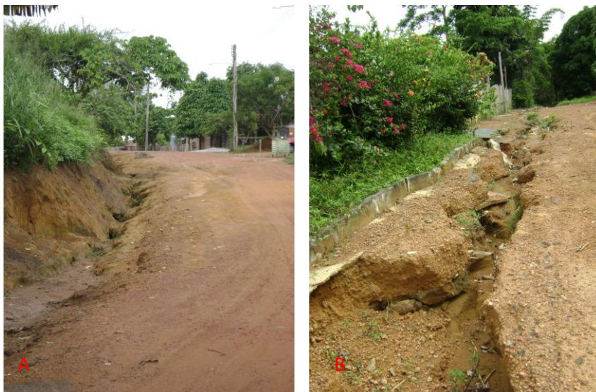
Figura 35 – (A) Erosão na R. Ivo Almeida, próximo ao campo de futebol; (B) Erosão em forma de sulcos na R. Ministro Marcos Freire próximo à Fundação Ágape. Fonte: Sarita de Moura.
