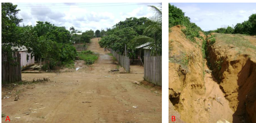
Figura 37 – (A) Baixada no Bairro Santo Elias com presença de alagamento em período de chuva; (B) Obra de tubulação para escoamento das águas das chuvas no Bairro Jardim Wilton. Fonte: Sarita de Moura.
