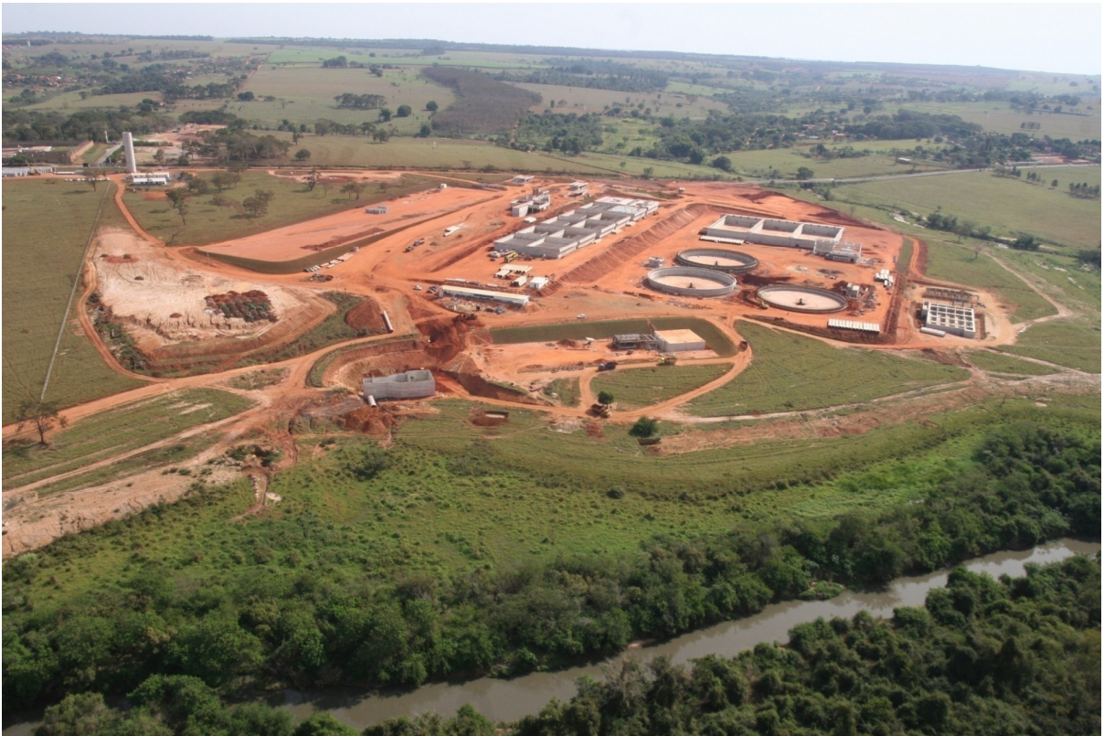
Figura 17 – Área de Instalação da E.T.E. Rio Preto Fonte: Arquivo institucional SeMAE
