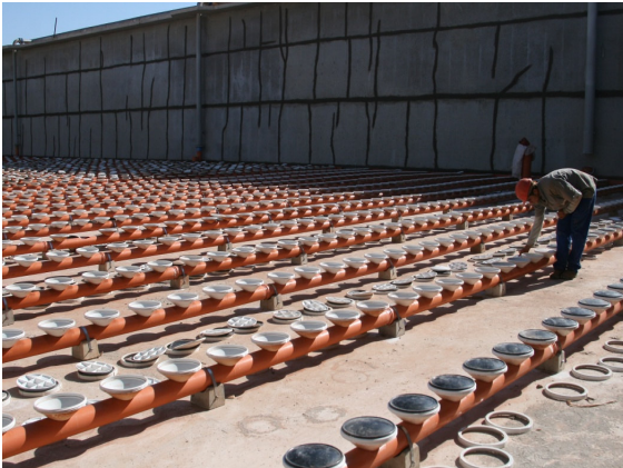
Figura 20 – Base do Tanque de Aeração
