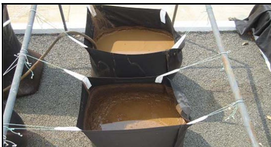
Figura 3.15 – Bags após despejo de lodo bruto ( ETA de Nova Odessa-SP). Fonte: Pessoa (2007).
