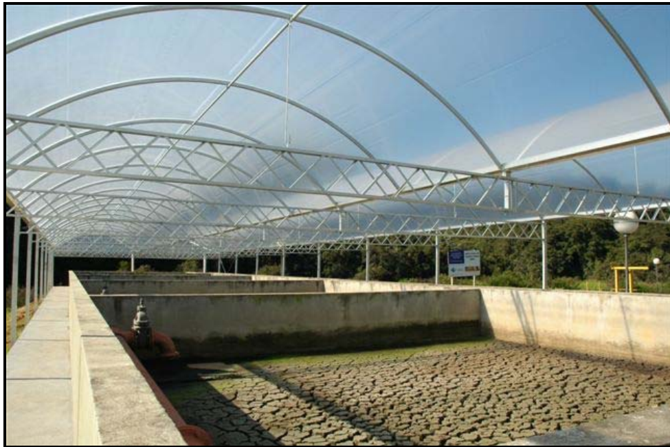
Figura 3.29 – Interior do leito de secagem coberto da ETE São Luiz do Paraitinga. Fonte: Van der Hoeven.
