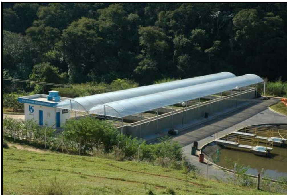
Figura 3.30 – Leitos de secagem cobertos (ETE São Luiz do Paraitinga). Fonte: Van der Hoeven.
