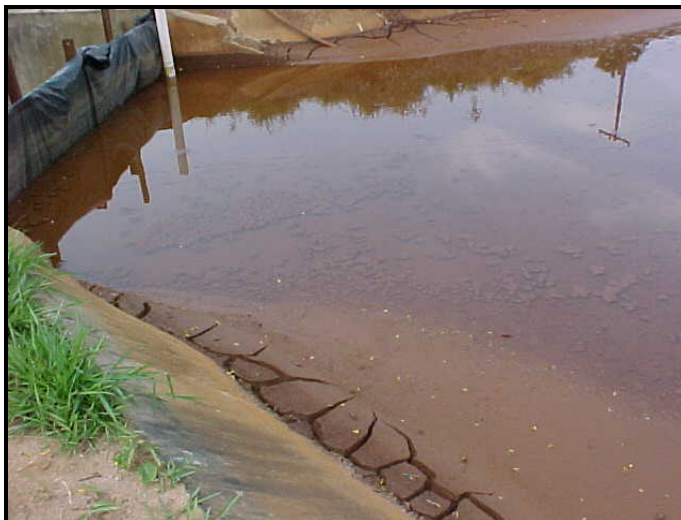
Figura 3.11 – Lagoa de lodo da ETA de Rio Claro-SP, após 45 dias do despejo. Fonte: Achon & Cordeiro (2003).
