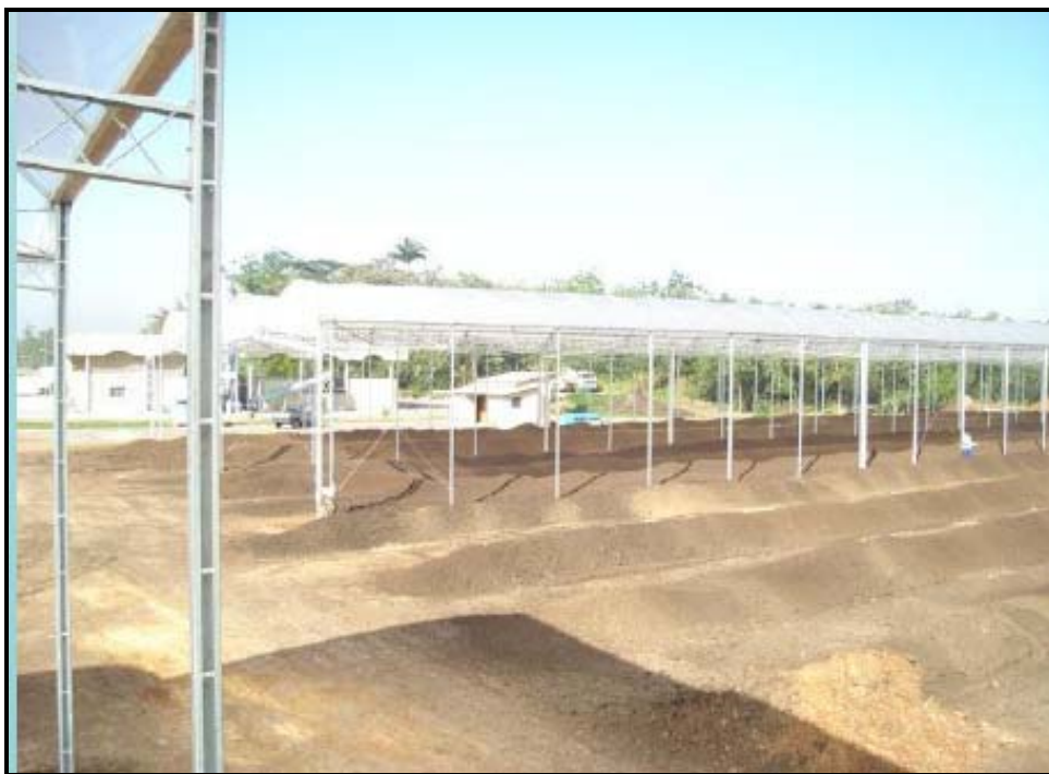
Figura 3.28 – Disposição do lodo de ETE em leiras de compostagem. Fonte: Oliveira (2008).
