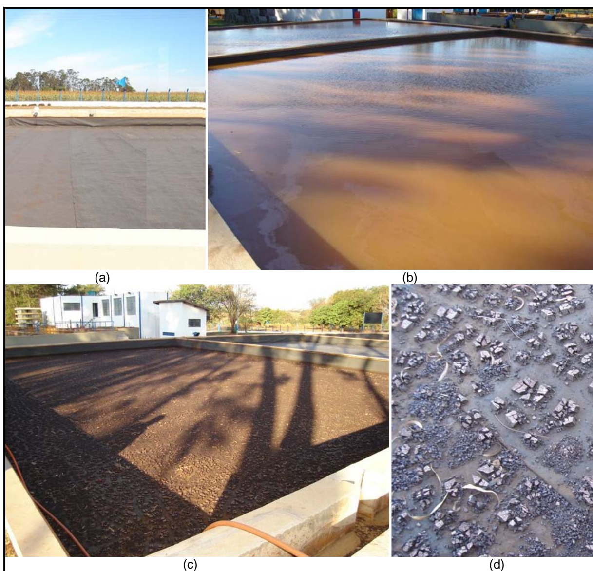
Figura 3.27 – Leito de drenagem ETA Guaíra: (a) disposição da manta geotêxtil; (b) leitos cheios; (c) leito de drenagem com lodo desaguado; (d) lodo “seco”.
