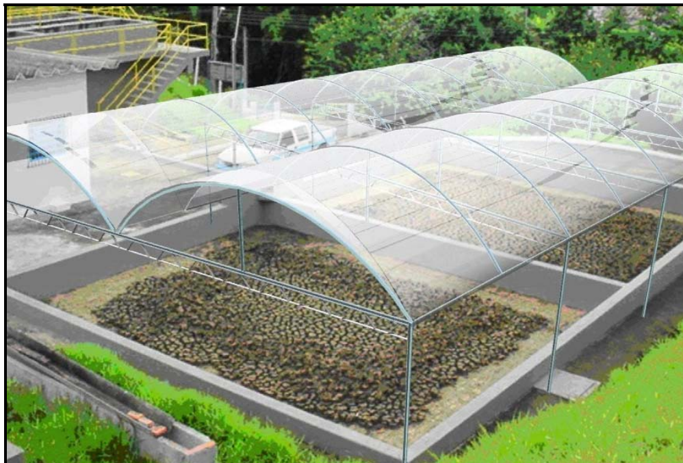
Figura 3.31 – Leito de secagem coberto (ETE Embaú). Fonte: Van der Hoeven.
