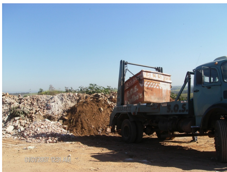
Figura 34 - Caçambas com RCC
