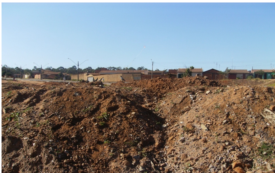
Figura 7 - Erosão na área, podendo comprometer a estrutura das residências locais.
