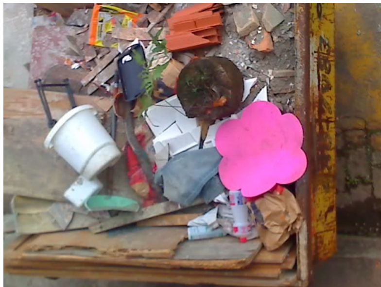
Figura 3 - Caçamba com presença de diversos resíduos e estacionada em local inadequado
