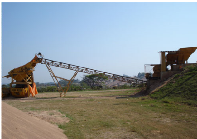
Pátio de recebimento e triagem dos RCC
