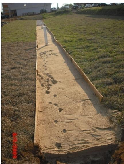
**Figura B.38.** Preenchimento da trincheira com areia.
