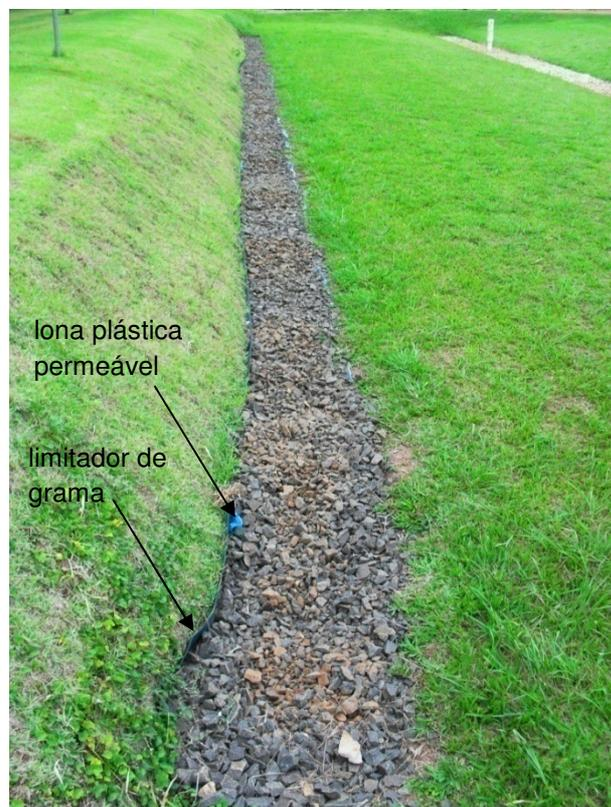
**Figura B.9.** Canal diafragma (manifold), após medida de manutenção.
