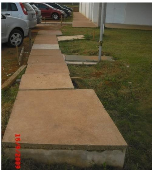
**Figura B.1.** Canaleta com tampas de concreto instaladas no período de construção.
