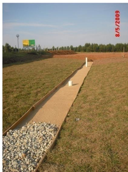
**Figura B.39.** Preenchimento da trincheira com seixo rolado.
