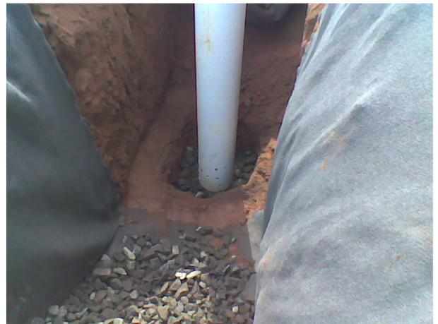
**Figura B.22.** Posicionamento do tubo de PVC de  $\varnothing$  200 mm e 225 cm de comprimento no quadrado delimitado.
