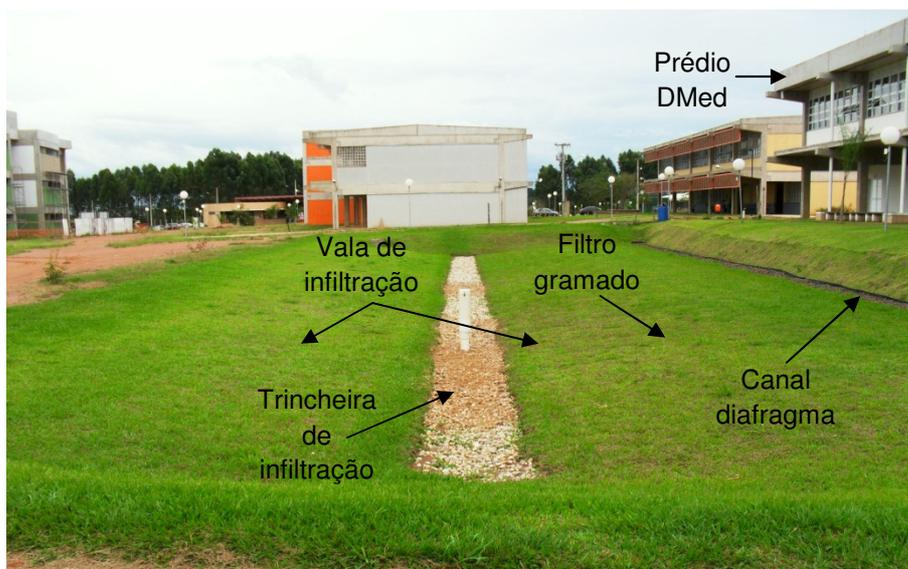
**Figura 5.4.** Sistema Filtro-Vala-Trincheira de infiltração
