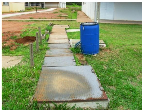
**Figura B.2.** Canaleta com tampas de metal durante o funcionamento do sistema.
