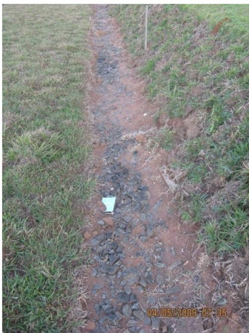
**Figura B.6.** Canal diafragma (*manifold*), com brita suja e acúmulo de sedimentos, logo após a construção do sistema.
