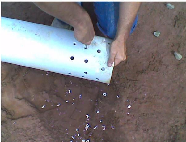
**Figura B.21.** Perfurações manuais com furos de  $\varnothing$  1/2" nos 10 cm inferiores do tubo.
