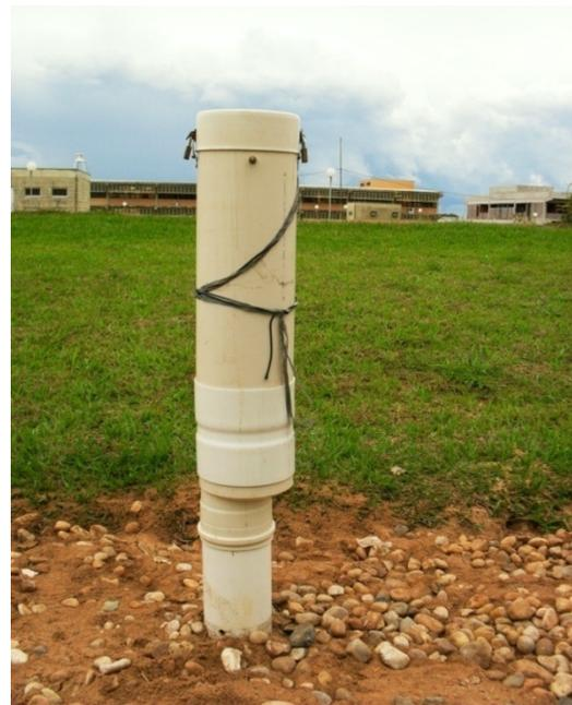
**Imagem 5.26.** Destaque para a fita do material de coleta disposta externamente no poço de monitoramento.
