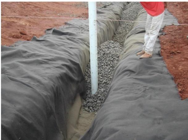
**Figura B.30.** Instalação do poço de monitoramento quantitativo.
