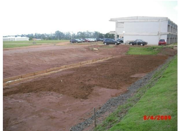
**Figura B.35.** Escarificação do solo.
