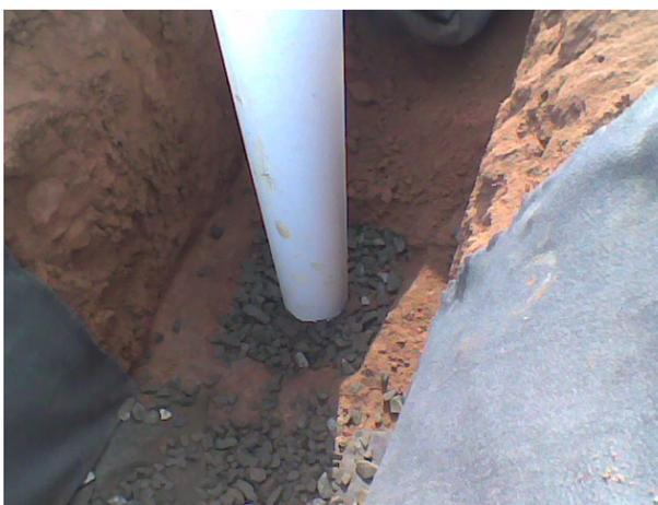
**Figura B.23.** Término de preenchimento do quadrado com brita.
