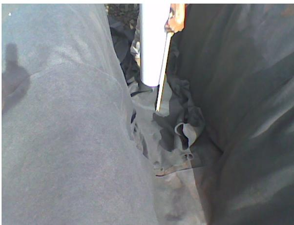
**Figura B.25.** Medição da extensão do geotêxtil (70 cm) do fundo da trincheira ao tubo de PVC.
