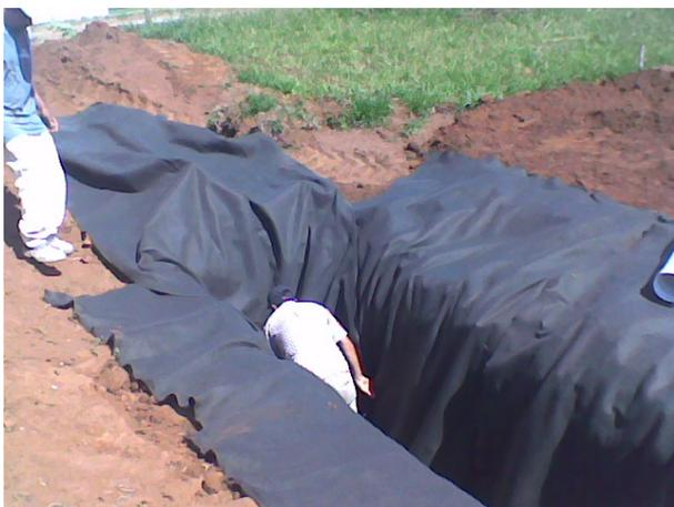
**Figura B.12.** Detalhe da colocação do geotêxtil na extremidade da trincheira.
