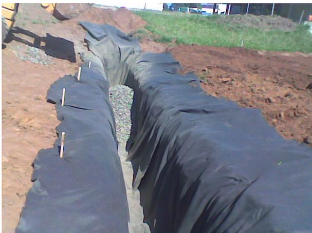
**Figura B.16.** Colocação da brita por trator com escavadeira.
