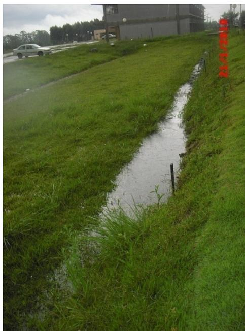
**Figura B.7.** Canal diafragma durante funcionamento do sistema em período chuvoso de 2010.
