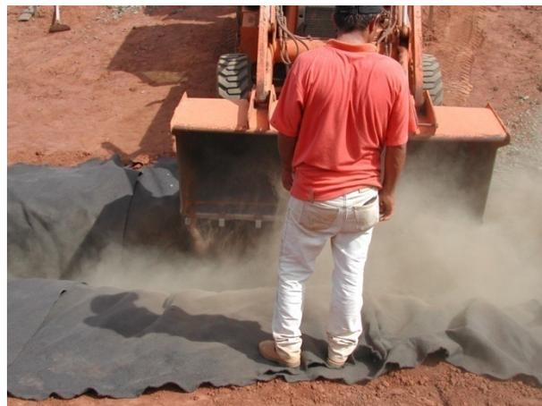
**Figura B.17.** Colocação da brita por trator com escavadeira.
