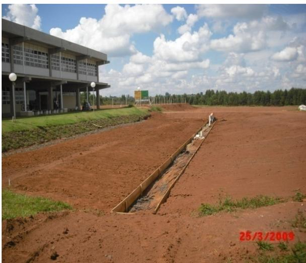
**Figura B.33.** Locação de madeira para proteção superficial.
