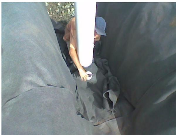
**Figura B.26.** Fixação do geotêxtil no tubo de PVC com fita adesiva plástica.
