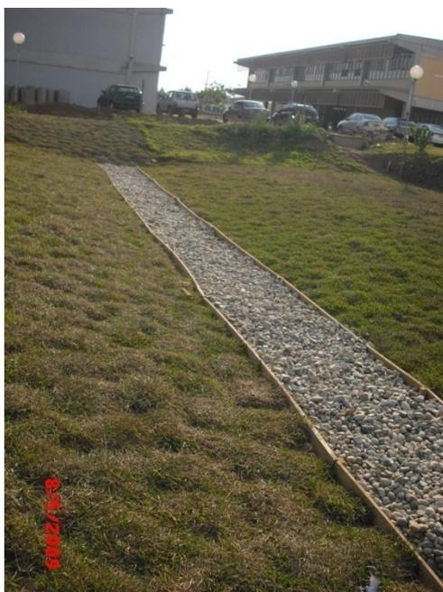
**Figura B.40.** Vista do preenchimento finalizado da camada de seixo rolado.
