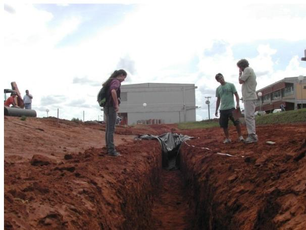
**Figura B.13.** Colocação do geotêxtil na extremidade da trincheira.
