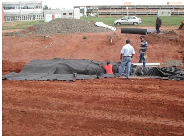
**Figura B.15.** Colocação do geotêxtil na extensão da trincheira.
