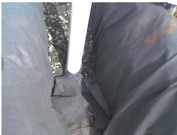
**Figura B.28.** Retomada do preenchimento com brita na área da trincheira.
