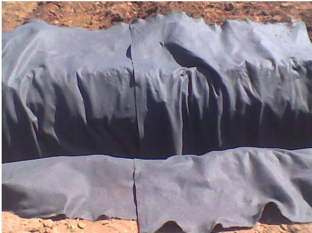
**Figura B.14.** Detalhe da colocação do geotêxtil na extensão da trincheira.
