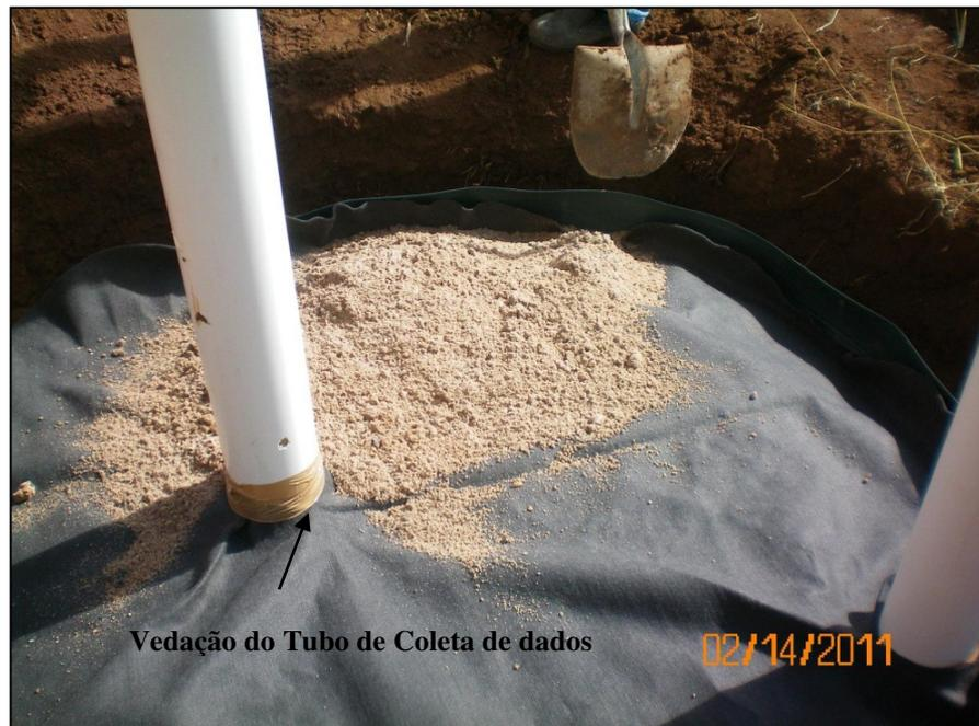
**Figura 50:** Vedação do tubo de coleta de dados na etapa de construção do poço de infiltração
