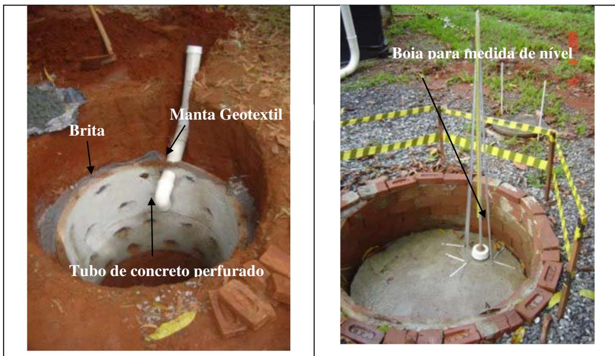
**Figura 5:** Detalhes construtivos do poço de Infiltração construído em escala real no campus da UFG, com volume de 1 m<sup>3</sup> e dimensões de 1,10 m de diâmetro interno, 1,30 m de profundidade, e preenchimento lateralmente com brita n. 1
