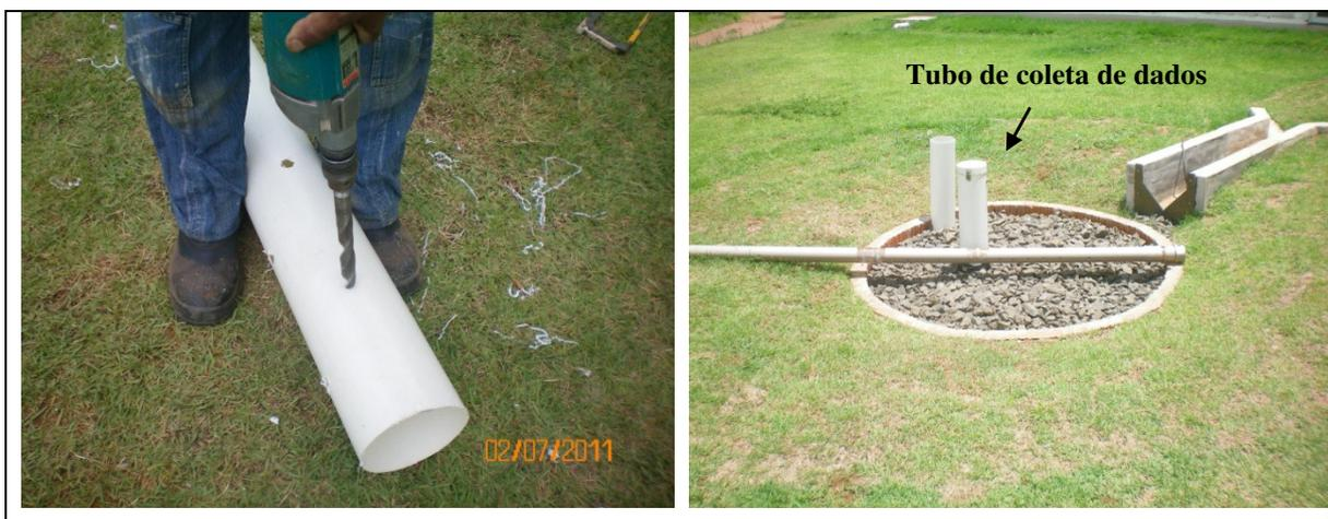
**Figura 20:** Tubo 150 mm de PVC com furos de 1,5 cm utilizado para coleta de dados
