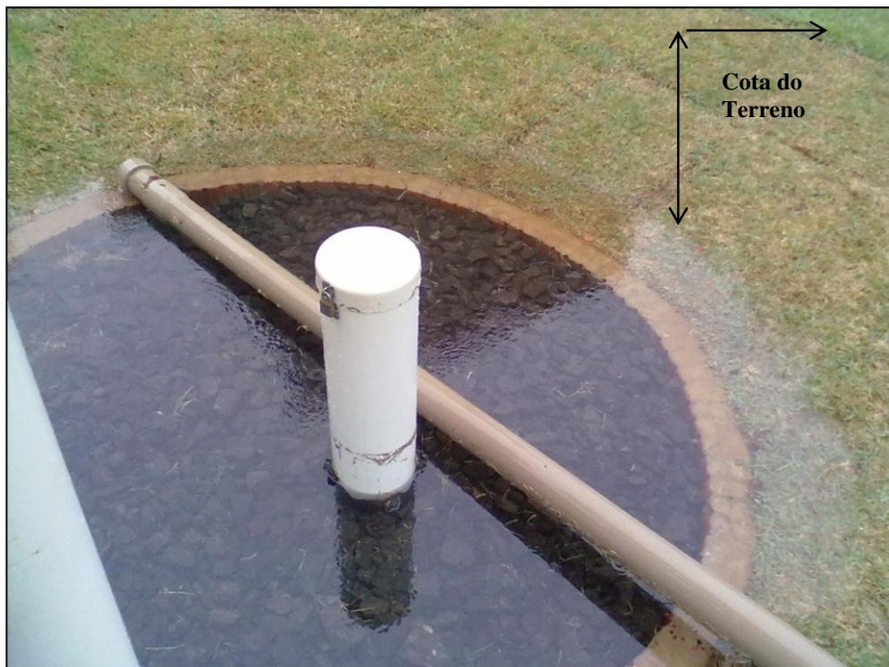
**Figura 52:** Evento monitorado com nível máximo de água de 1,90 m que ultrapassou o limite do volume de controle do poço de infiltração
