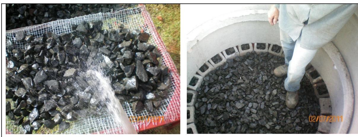
**Figura 22:** Lavagem da brita para utilização da mesma no fundo e na tampa do poço
