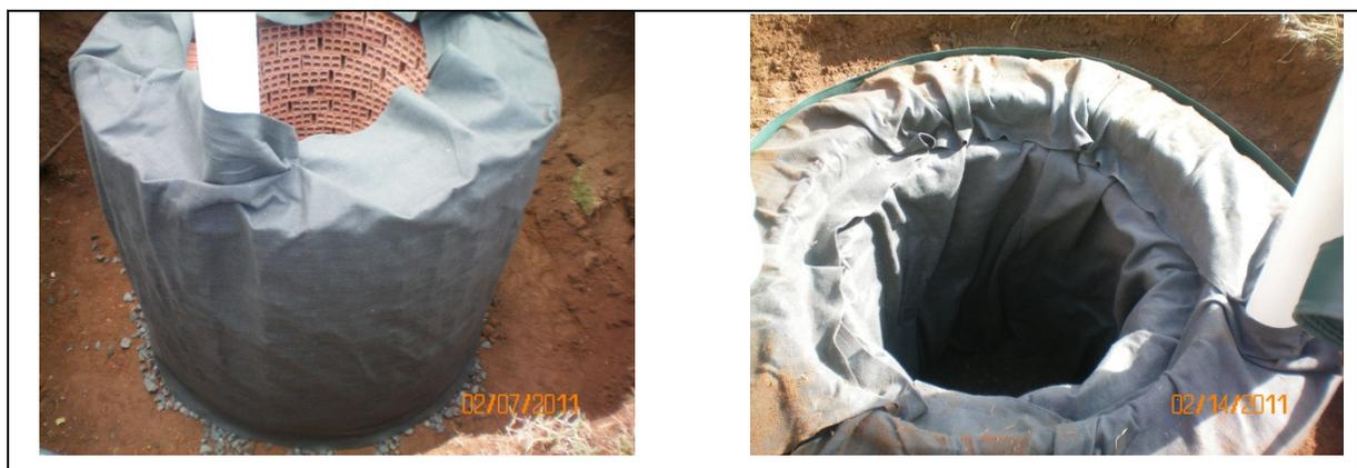
**Figura 18:** Manta geotêxtil colocada nas paredes internas e externas do poço de infiltração
