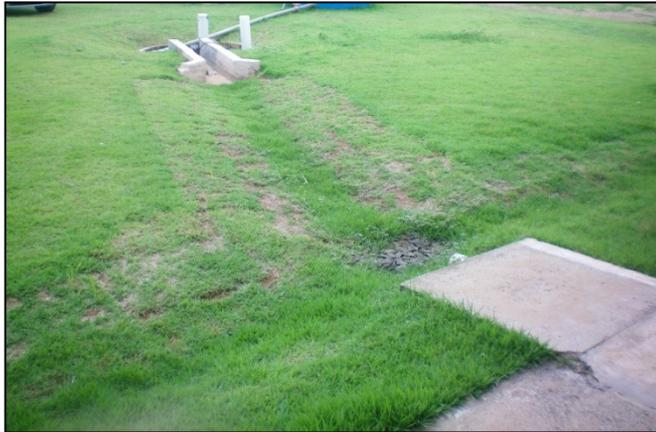
**Figura 23:** Canaletas gramadas para condução da água pluvial proveniente do telhado ao poço de infiltração
