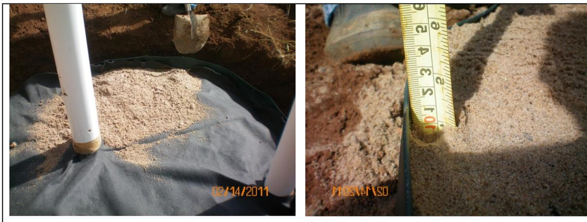
**Figura 21:** Camada de 10 cm de areia colocada em cima da tampa de metal sobre a manta geotêxtil no início da construção do poço de infiltração
