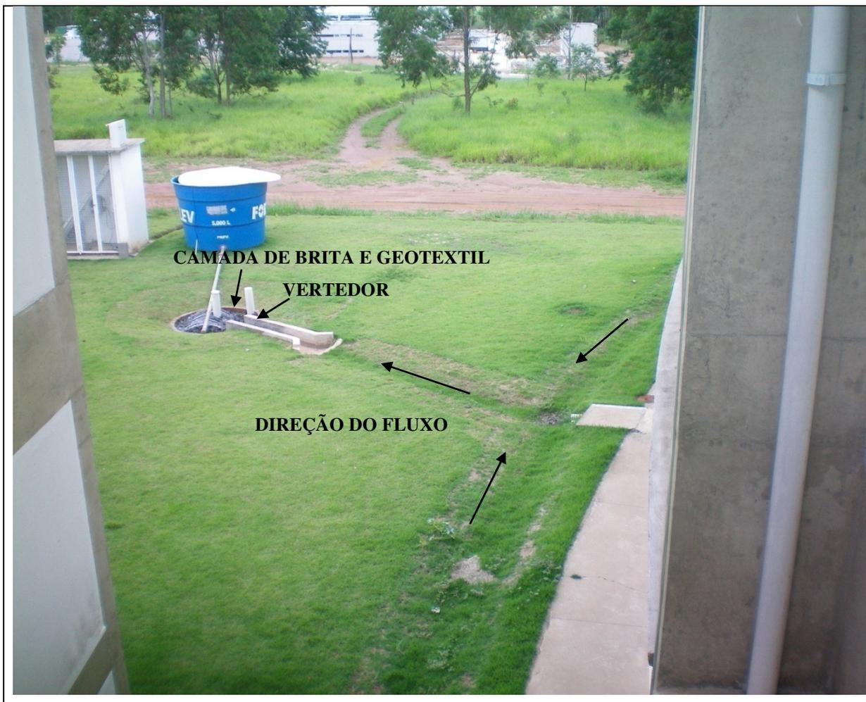
**Figura 24:** Esquemas de alimentação do poço de infiltração: caminho das águas do telhado do prédio ao poço de infiltração por meio das canaletas gramadas
