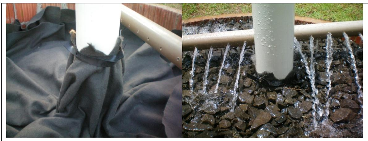
**Figura 42:** Vedação do tubo de coleta e entrada de água no poço por meio do filtro da tampa
