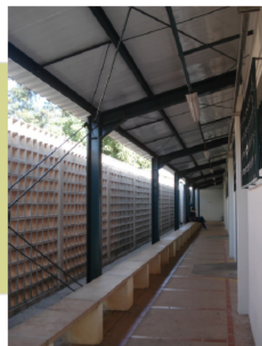
Figura 6. Ed. 92 AT3. Vista interna. Foto da Autora (07/2011).
