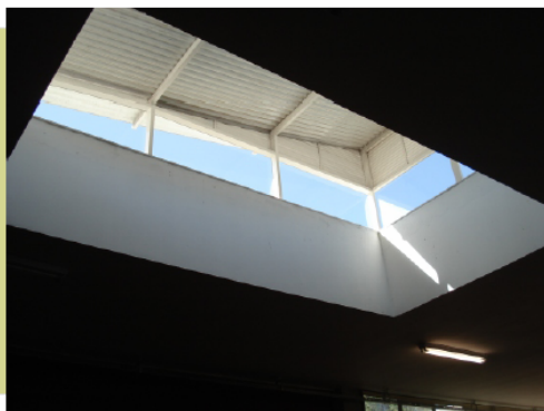
Figura 19. Ed. 52 DF - 1980. Iluminação zenital (reforma 2008). Foto da Autora (07/2011).
