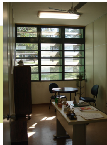
Figura 16. Ed. 50 SIn - 1979. Sala de TA (brise face norte). Foto da Autora (07/2011).
