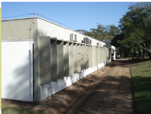
Figura 9. Ed. 52 DF - 1980. Brises - face norte. Placa cimentícia e chapa metálica perfurada. Foto da Autora (07/2011).
