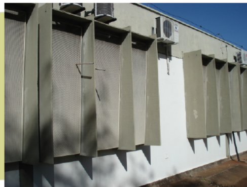
Figura 10. Ed. 52 DF - 1980. Detalhe de brise. Reforma 2008. Foto da Autora (07/2011).
