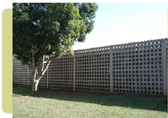
Figura 5. Ed. 92 AT3 -1991. Vista externa. Foto da Autora (07/2011).
