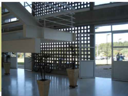
Figura 7. Ed. 143 AT7 - 2009. Hall de entrada - face sul. Foto da Autora (07/2011).
