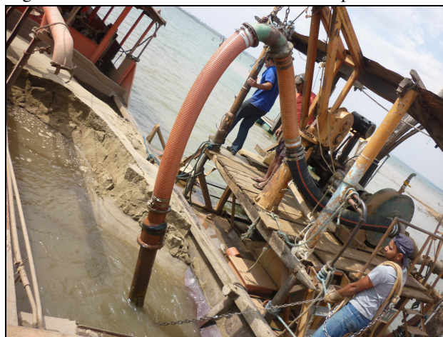
Figura 9 – Bombeamento da areia no até as peneiras
