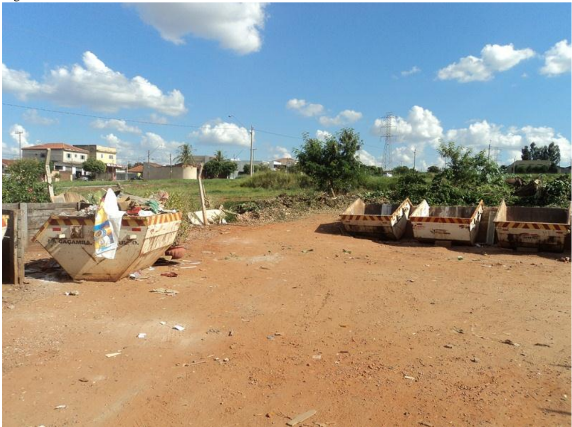
Figura 18 – Foto do PA Jd. Atlântica com o cercamento danificado ao fundo.
