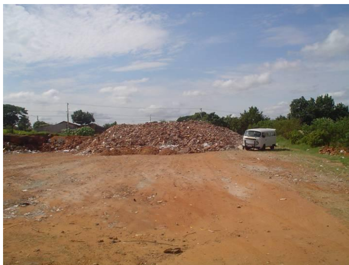
Figura 12 - Foto de um Ponto de Apoio Jd. Anna Angélica sem as estruturas adequadas para a gestão de resíduos, com concentração de resíduos da construção civil.
