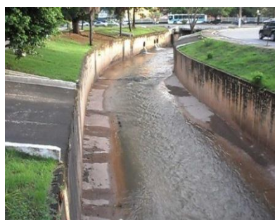
Figura 4.5. Trecho canalizado em concreto. Fonte: Acervo pessoal.
