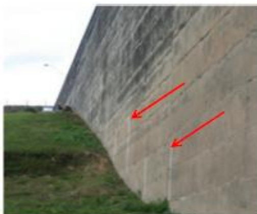
Figura 3.6. Escala pintada sobre superfície vertical. Fonte: (BRASIL, 2009).
