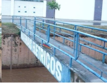
Figura 5.9. Passarela sobre a seção de monitoramento
