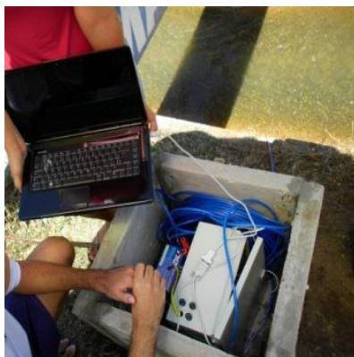
Figura 5.11. Instalação do linígrafo
