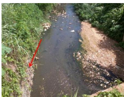
Figura 4.4. Trecho canalizado com gabião. Fonte: Acervo Pessoal
