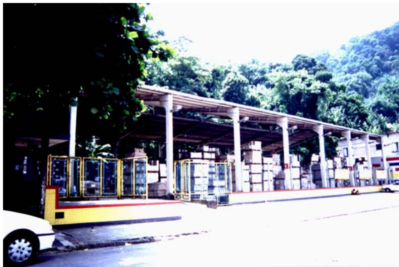
Figura 16 – Galpão clandestino: o zoneamento do local não permite a atividade que continua em funcionamento: depósito de materiais de construção. Fonte: Maria Valquíria de Souza Barbosa.
