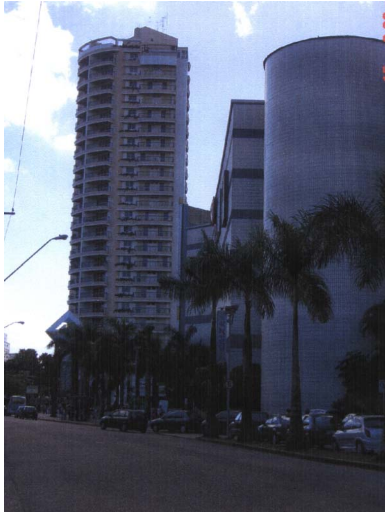
Figura 21 – Edifício de luxo construído pelo empresário Armênio Mendes. Na Cobertura do edifício foi construída uma laje que não consta no projeto aprovado e licenciado. Essa laje caracteriza mais um pavimento, transgredindo, portanto, as leis vigentes. Somente com uma lei de anistia, o empreendimento poderá obter o “habite-se”. Fonte: Maria Valquíria de Souza Barbosa.
