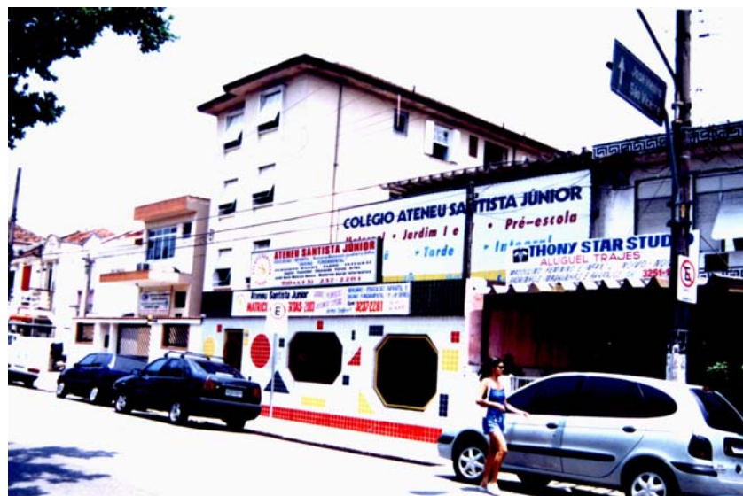
Figura 18 – Unidade de Ensino executou obra clandestina: cobertura e fechamento do recuo frontal. No imóvel à direita da escola, constamos um telheiro no recuo frontal, também irregular.
