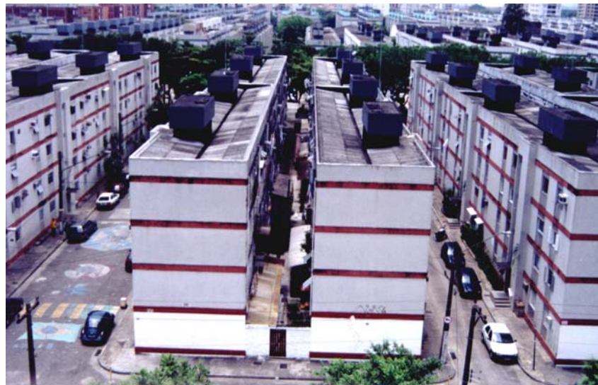
Figura 14 – Recuos de fundos – áreas comuns do condomínio sendo ocupadas irregularmente.
