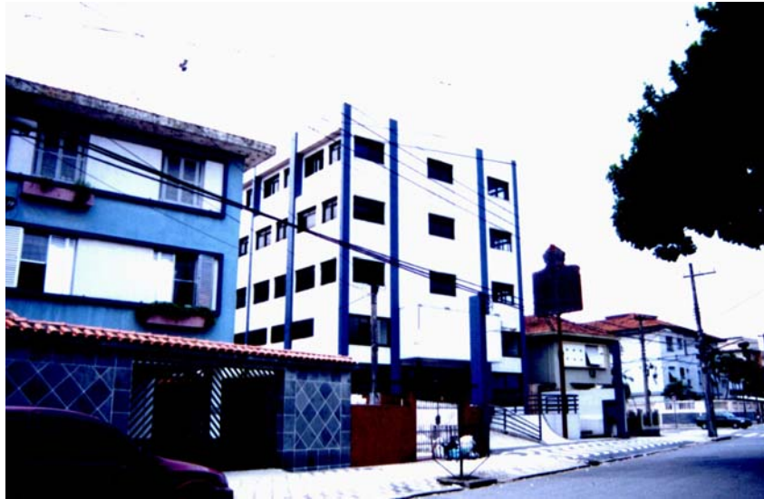
Figura 17 – Edifício clandestino de 05 pavimentos: no local, já funcionou até um supermercado, mas foi desativado, pois teve seu alvará de funcionamento cassado.
