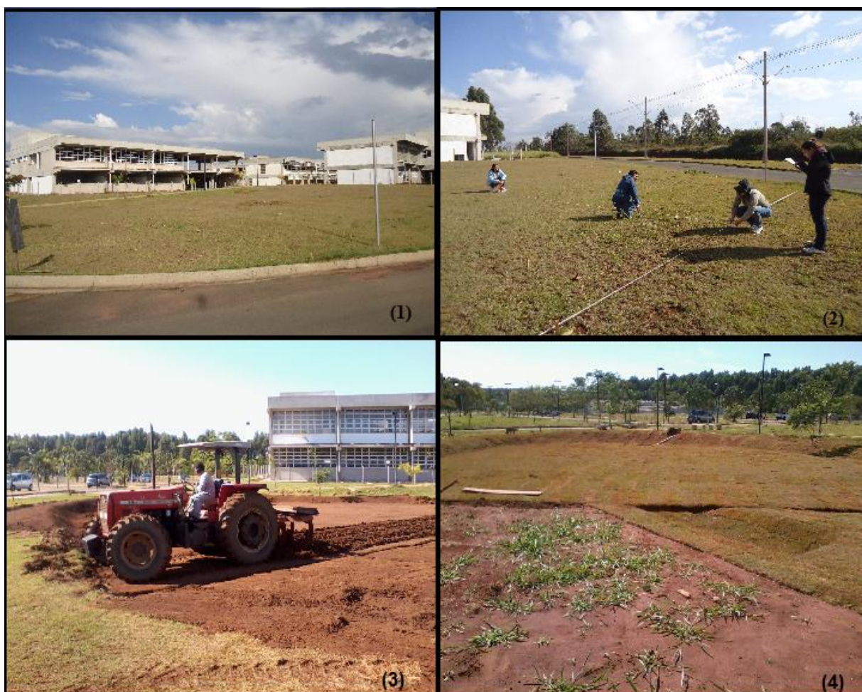
Figura 25 - Área do Plano de Infiltração (1). Localização da Obra (2). Subsolação da área (3). Plantio de grama (4). Fonte: Grupo G-Hidro.
