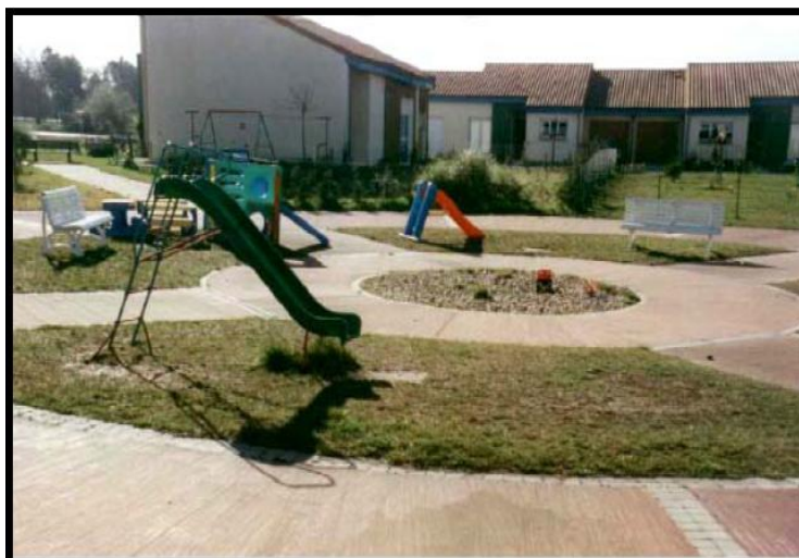
Figura 7 - Poço de Infiltração construído em uma área de recreação em Lyon, França. Fonte: Baptista et al. (2011).
