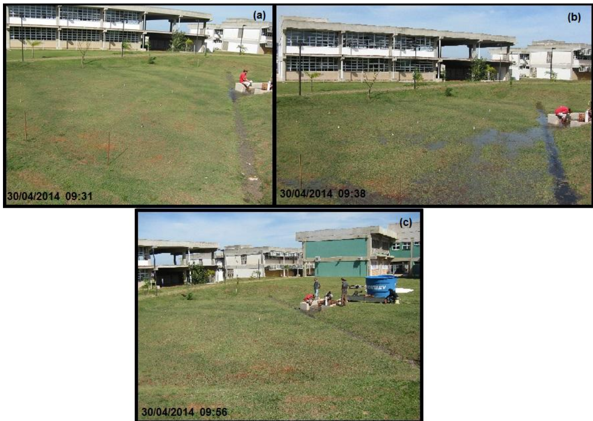
Figura 37 – Ensaio de campo 1 com caixa de água e caminhão pipa: (a) início do ESD no plano (09:31), (b) momento com máxima área molhada (09:38), (c) final da infiltração no plano (09:56)
