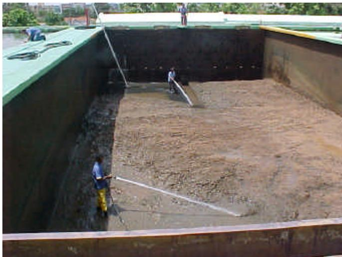
**FIGURA 4.5** – Funcionários da limpeza no interior do decantador forçando o escoamento do lodo com jatos de água.
