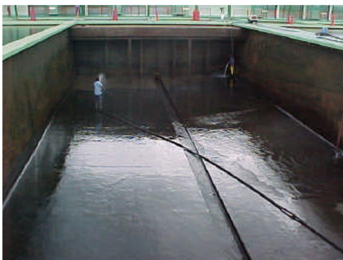
**FIGURA 4.6** – Visão do fundo do decantador praticamente limpo.
