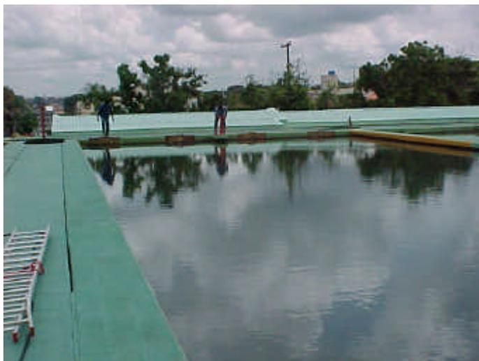
**FIGURA 4.4** – Fechamento das comportas de entrada de água e abertura das adufas de fundo do decantador para o escoamento do lodo.
