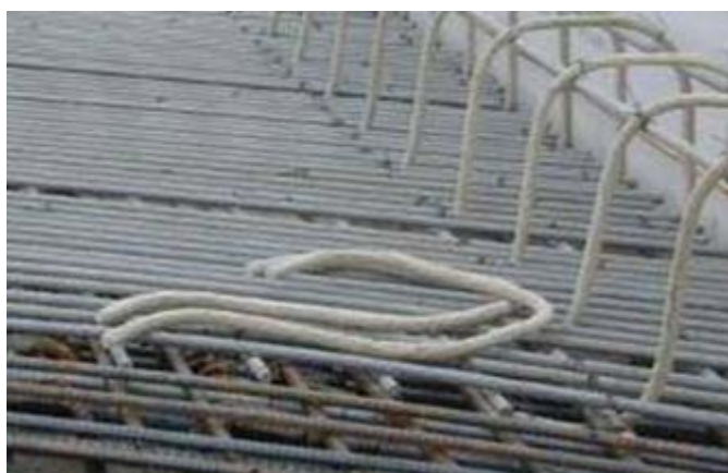
c – Detalhe de armadura em GFRP pré-fabricada – USA
