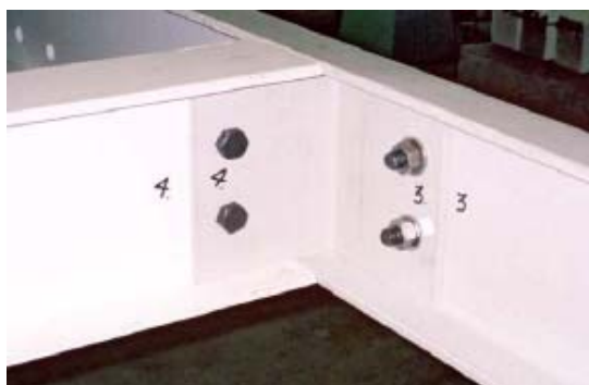
a – Ligação viga – viga
