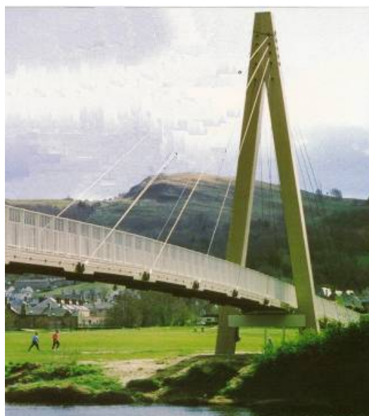
Figura 64 - Passarela para pedestres construída na Irlanda em 1999 Fonte: AMOCO - British Petroleum (1999)
