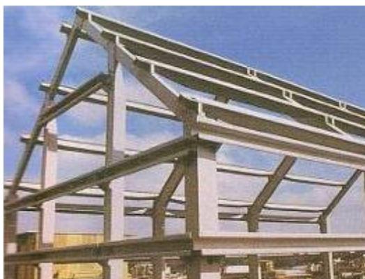
Figura 63 - Estrutura de GFRP recoberta com policarbonato Fonte: Saint-Gobain – VETROTEX (2003)
