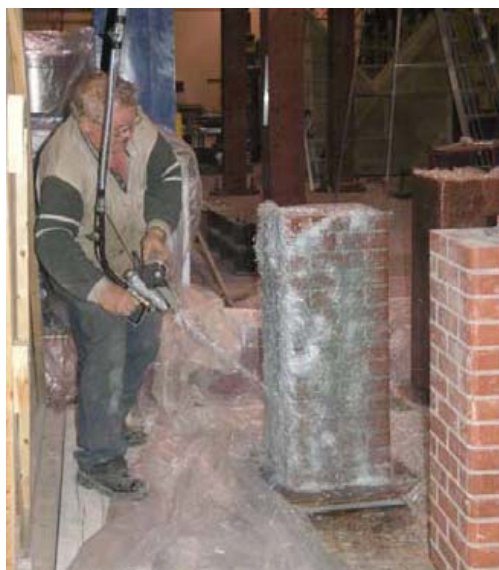
Figura 110 – Aplicação do GFRP sobre o pilar de alvenaria Fonte: Shaheen & Shrive (2005)
