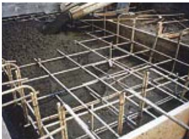
Figura 74 - Estrutura de fundação para laboratório de hospital com armadura de barras de GFRP – USA Fonte: HUGHES BROTHERS INC. (2001)
