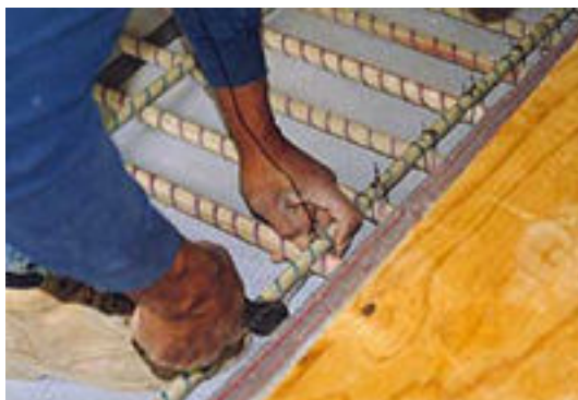
b – Detalhe de amarração de armadura de sapata
