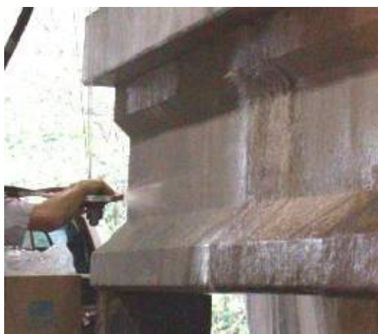
Figura 90 – Aplicação de fibra por projeção ( spray-up ) Fonte: Rehm (2005)
