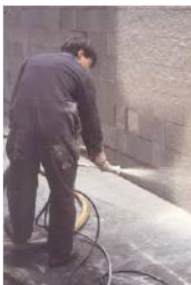
Figura 45 – Aplicação de CGFRP sobre alvenaria.
