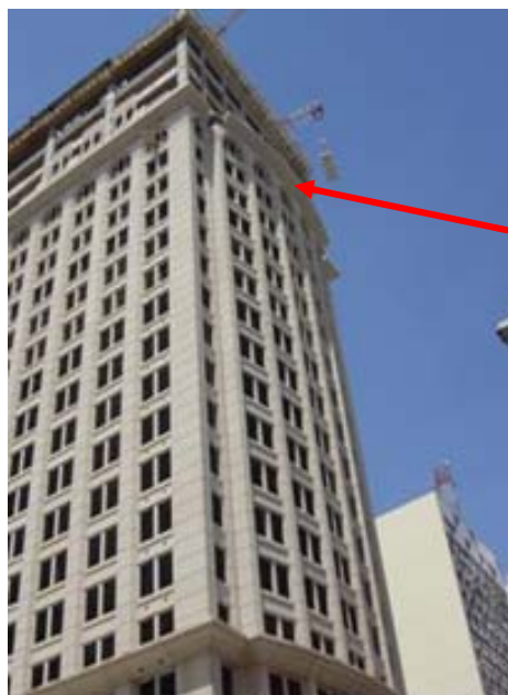
“a” - Aplicação em fachada arquitetônica
