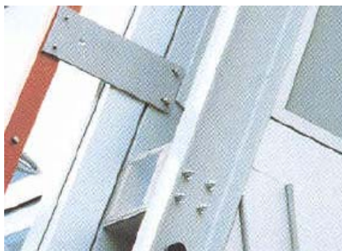
c – ligação pilar – painel
