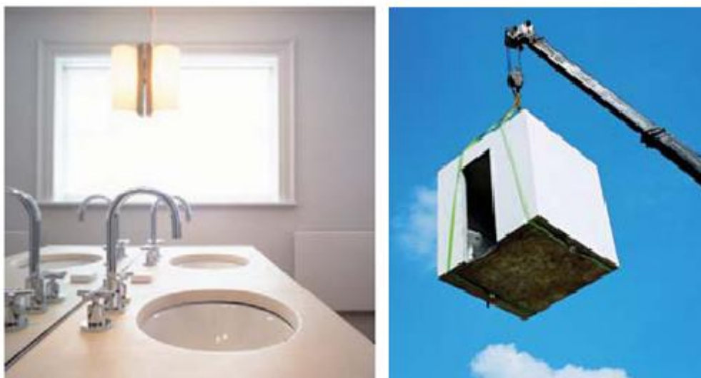
“a” – área interna de banheiro pronto
