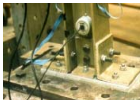
d – Ensaio de ligação pilar- fundação
