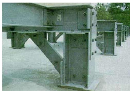
b – ligação viga - pilar
