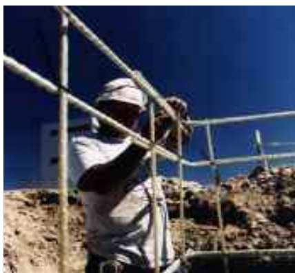
a – Aplicação de barras de GFRP em cortina de concreto – Porto Rico
