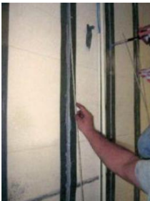
Figura 72 – Aplicação de barras circulares de GFRP como reforço estrutural em alvenaria. Fonte: HUGHES BROTHER, Inc. (2006)
