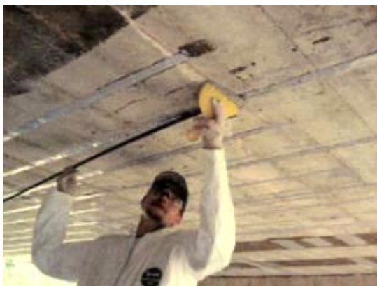
Figura 71 – Reforço executado com barras chatas híbridas de GFRP e CFRP em ponte nos EUA Fonte: HUGHES BROTHERS Inc. (2006)
