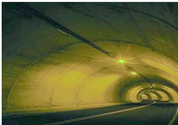
Figura 54 – Túnel construído com GRC projetado sobre concreto armado com GFRP Fonte: HUGHES BROTHERS, Inc. (2005)
