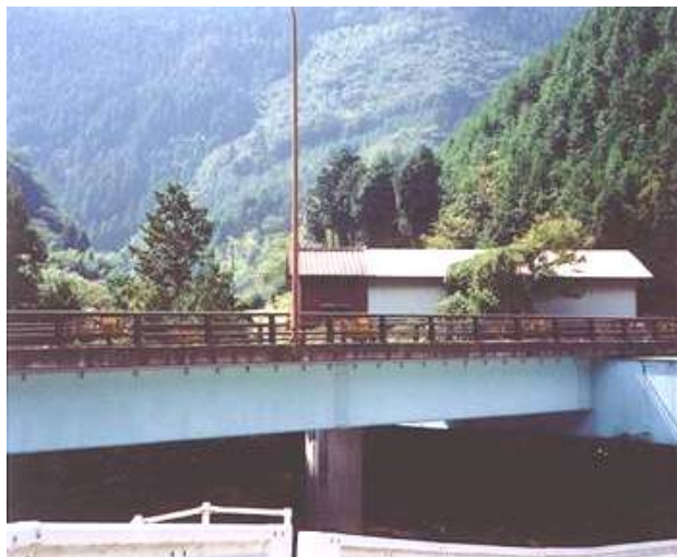
Figura 67 – Ponte “ Tsukuyda ” Fonte JSCE (2006)
