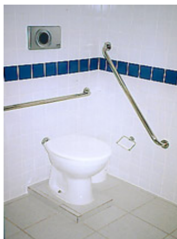
“c” – Detalhe de um banheiro escolar
