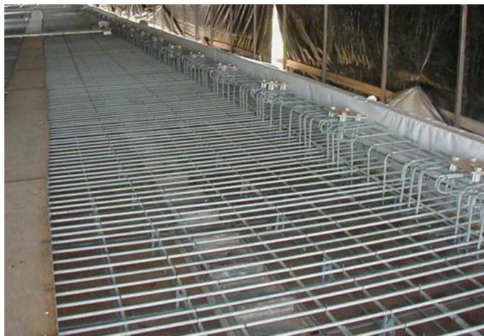
d – Vista armadura de laje de ponte em GFRP com estribos consolidados à armadura principal.
