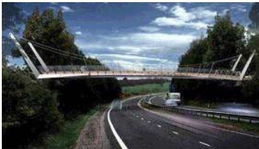
Figura 65 – Passarela para pedestres construída no Reino Unido em 2005 Fonte COBRAE (2004)
