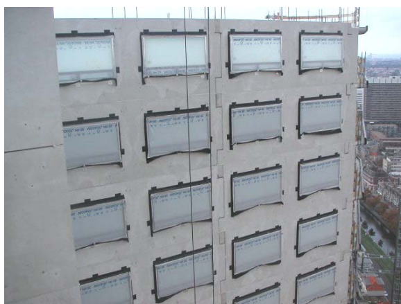
Figura 59 – GRC associado à armadura estrutural em painéis estruturais Fonte: (FERREIRA, 2007)
