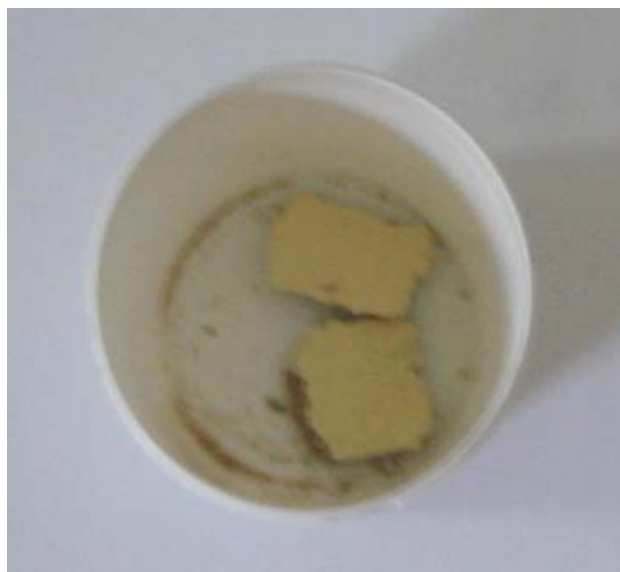
Figura 3.9– Amostra do revestimento de argamassa da casa 1, denominada casa com evidência de bolor.
