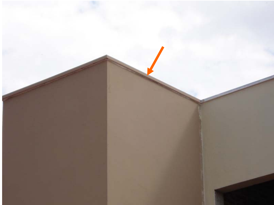
Figura 2.2 – Foto que ilustra a pingadeira na parte superior da edificação.
