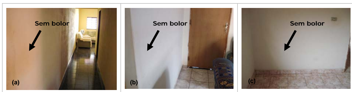
Figura 3.3– Casas aparentemente sãs – casa 4 (a), casa 5 (b) e casa 6 (c)
