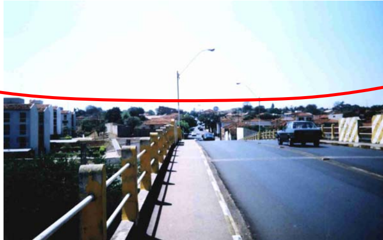
Figura 4.4: Foto do Viaduto (Av. 22 de Agosto)
