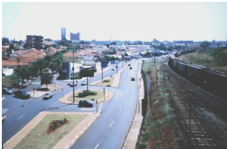
Figura 4.2: Vista do Viaduto da Av. Barroso – Abaixo a Av. Maria A C. de Oliveira sobre o Córrego da Servidão (registro: 09/2003).
