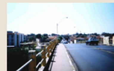
Vista do Viaduto da Av. Barroso Tipologia urbana a leste da ferrovia. Padrão de ocupação (1 e 2 pavimentos). ↑
