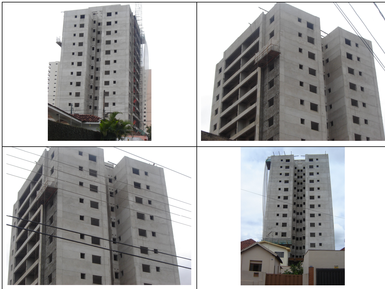
Foto 3 - Vistas da obra com a atividade de revestimento externo em andamento - Obra C.
