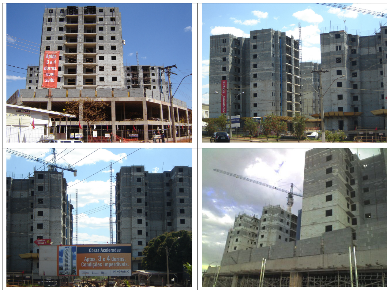
Foto 2 - Vistas da obra durante a etapa da superestrutura e alvenaria - Obra B.
