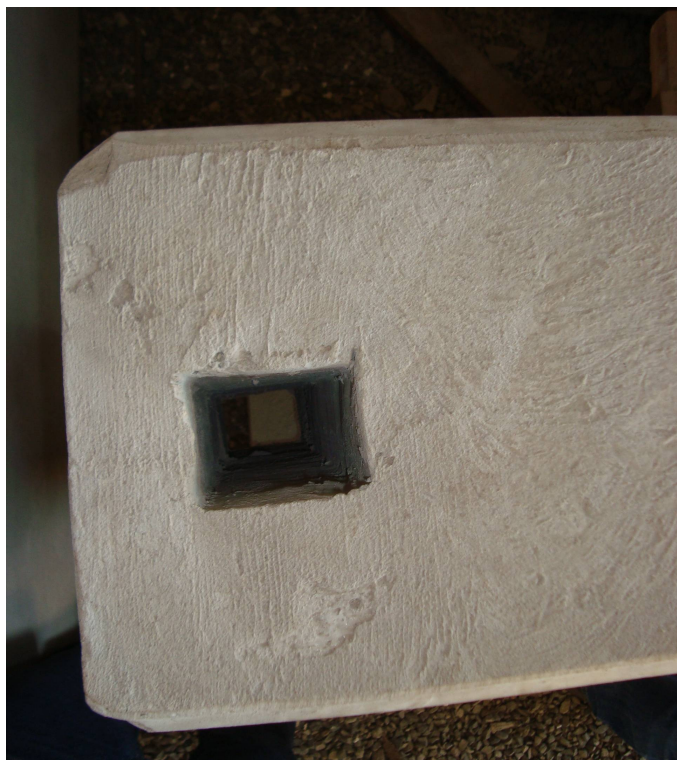
Figura 42: Detalhe da furação da viga pré-fabricada para posicionamento do chumbador.
