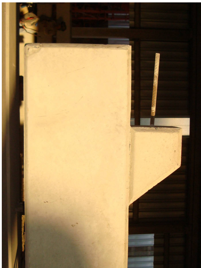
Figura 41: Detalhe do consolo e chumbador em um pilar pré-fabricado.
