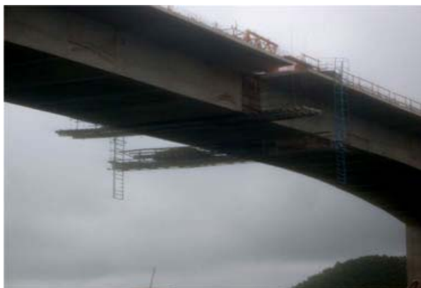
Figura 1.12. Fechamento do vão central. Ponte em balanço progressivo na Represa Billings, construção do Rodoanel Mario Covas (Fonte: DERSA, 2010)
