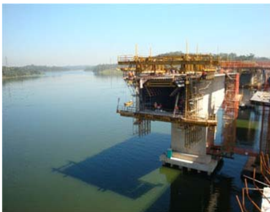
Figura 1.10. Ponte em balanço progressivo na Represa Billings, Rodoanel Mario Covas (Fonte: DERSA, 2010)
