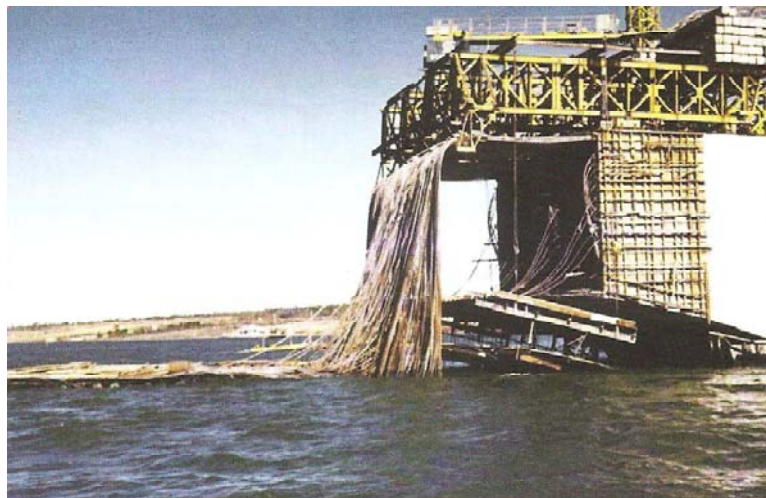
Figura 2.11. Aspecto dos cabos pendentes e mergulhados no lago depois da forte ventania de julho de 1970 (Fonte: VASCONCELOS, 2009)
