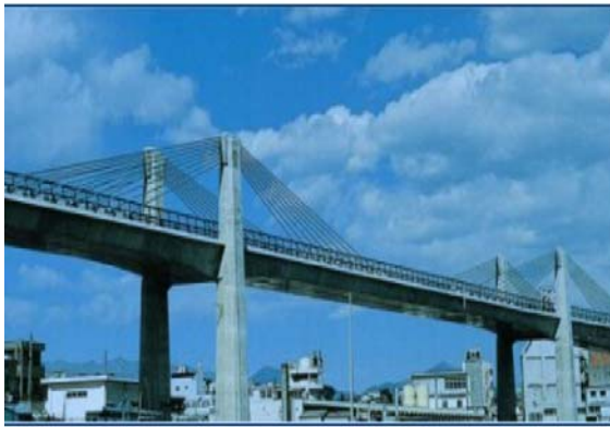
Figura 2.9. Odawara Blue Way Bridge (Fonte: ISHII – 2006)
