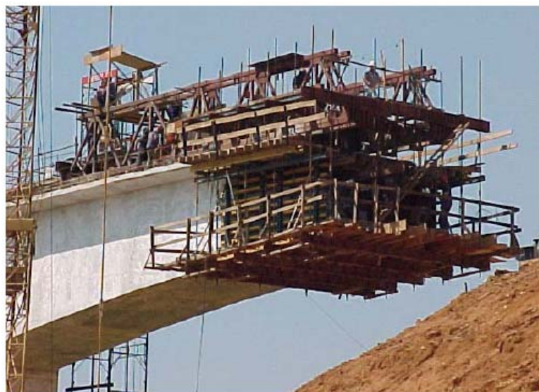
Figura 1.3. Balanço progressivo moldado no local (Fonte: MATTOS, 2001)
