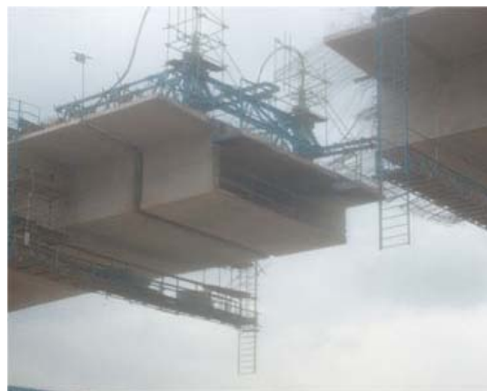
Figura 1.11. Ponte em balanço progressivo na Represa Billings, Rodoanel Mario Covas (Fonte: DERSA, 2010)
