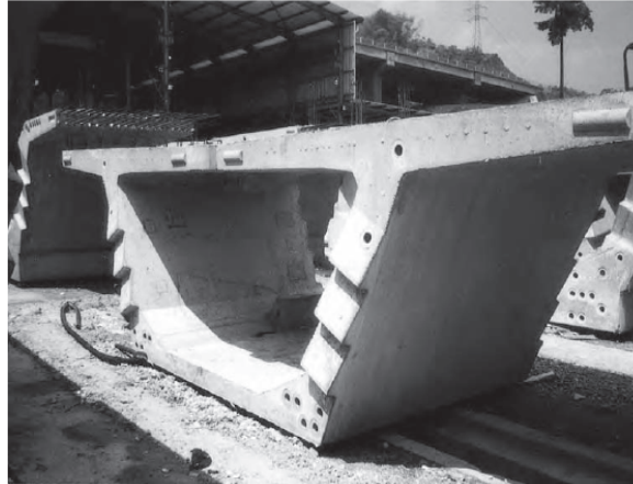
Figura 3.5. Chaves de cisalhamento: protuberâncias (Fonte: BENAİM, 2008)
