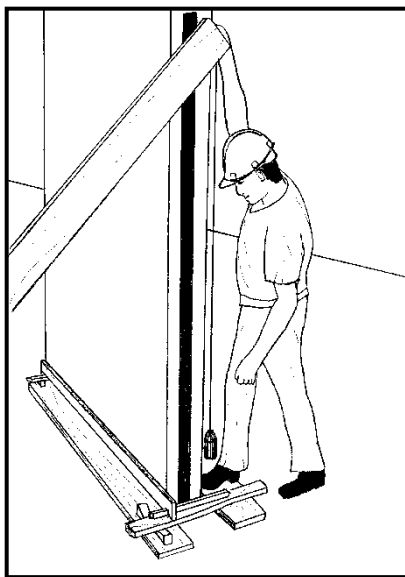
Figura 19 – Montagem de fôrma de pilar com conferência de prumo. (Arquivo do autor).
