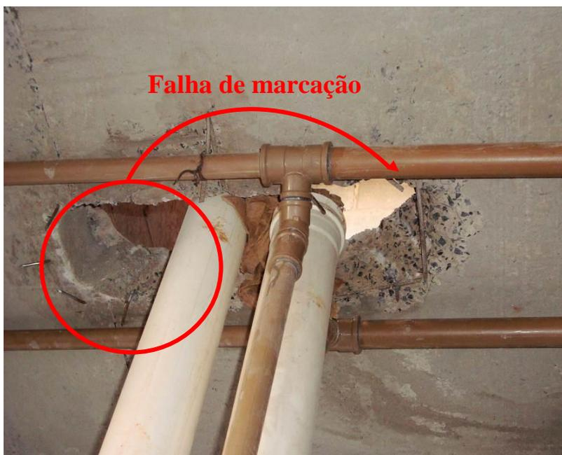
**Figura 18 – Retrabalho da execução por falha de marcação na passagem de tubulação**
