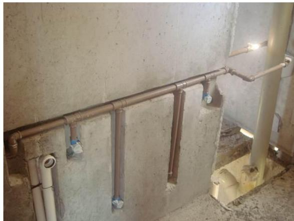
**Figura 27 – Exemplo de cortes para assentamento de tubulações em paredes pré-moldadas em concreto**
