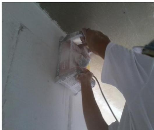
**Figura 48 -Equipamento utilizado para corte e rasgo da alvenaria de gesso**
