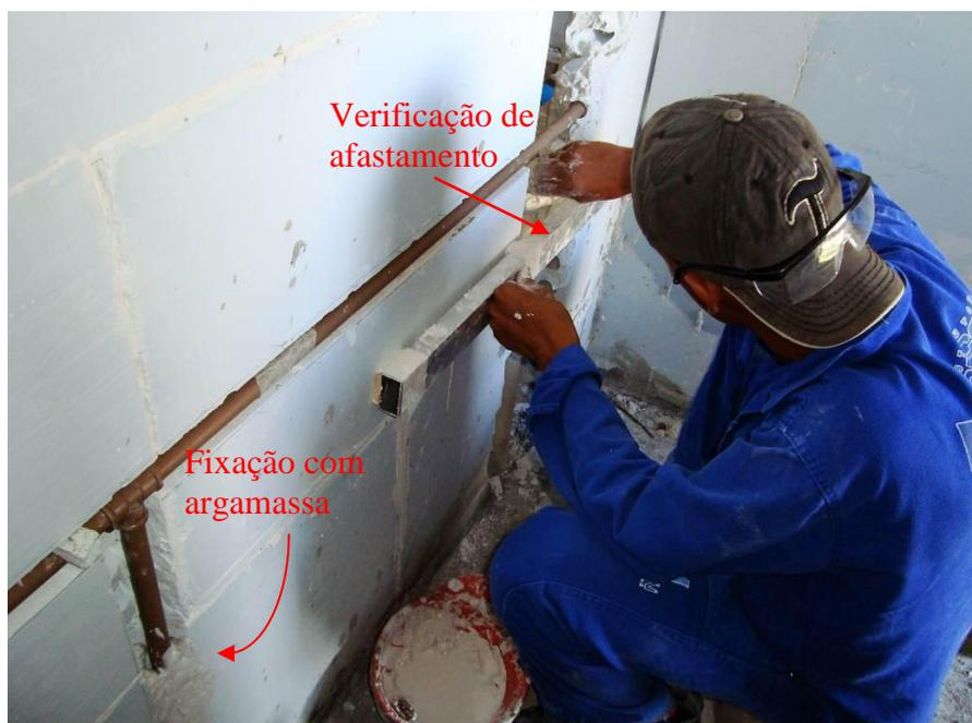
**Figura 35 – Representação de fixação de tubulação de PVC em paredes com argamassa de gesso**
