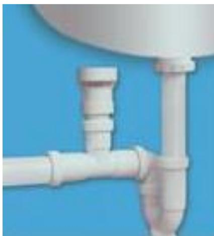
**Figura 17 - Válvula de admissão no ramal de esgoto (AECweb, 2010)**
