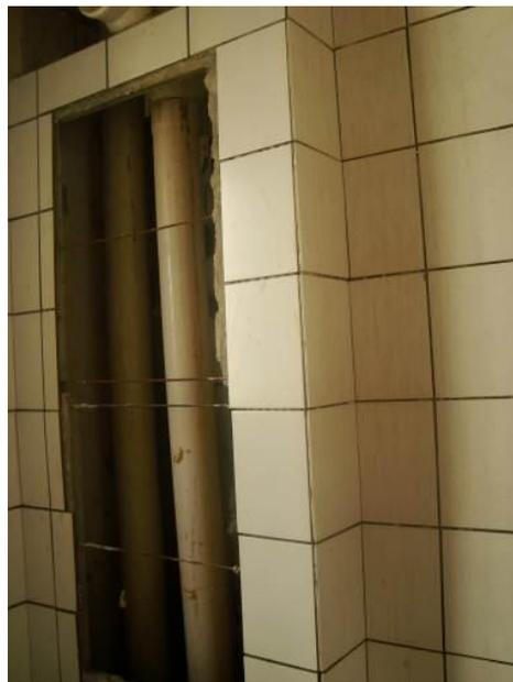
**Figura 25 – Representação de tubulação embutida na parede utilizando *shaft***
