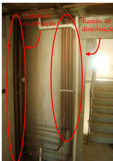
**Figura 49 -Representação de esquema semelhante a saída dos ramais da coluna de distribuição (MATOS; PALIARI, 2010)**
