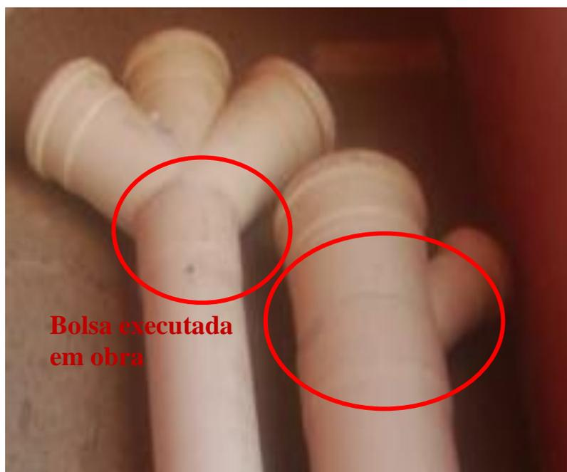
**Figura 20- Exemplo de execução fora das especificações do fabricante**
