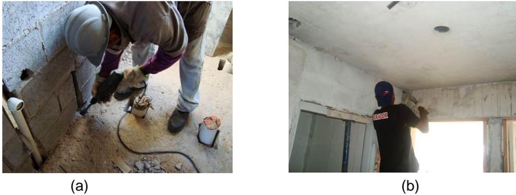
**Figura 24 - Exemplos de execução de passagens após concretagem (a) utilizando furadeira e (b) utilizando marreta e ponteiro**
