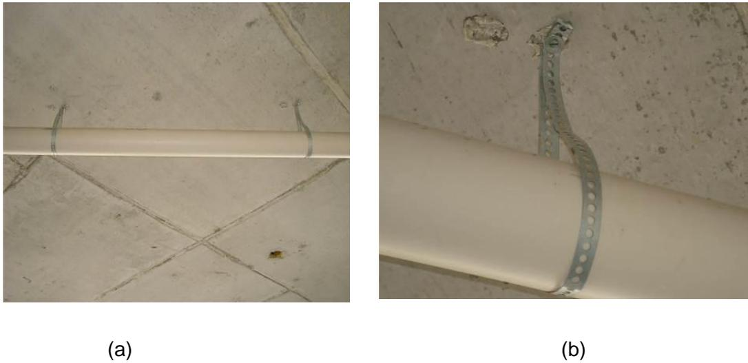
**Figura 33 – Representação da utilização de pinos e fitas de aço para fixação das tubulações: (a) Geral; (b) Detalhe**
