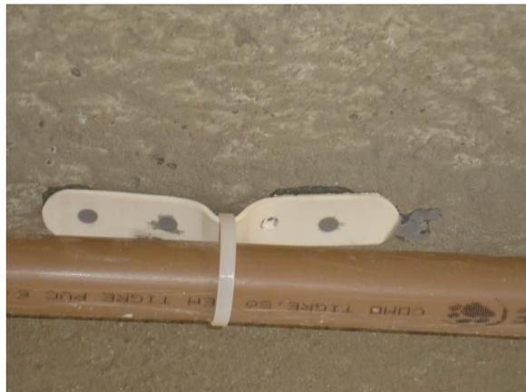
**Figura 34 – Representação de fixação de tubulação utilizando sobra de material**
