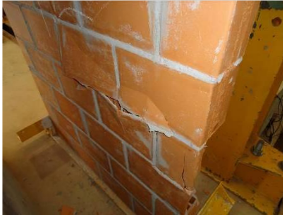
Figura 34 – Parede P2 após ruptura
