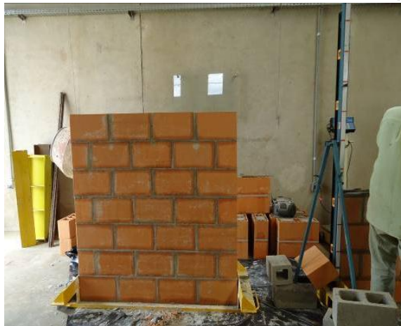
Figura 21 – Parede sendo confeccionada sobre chapas metálicas
