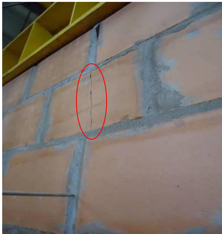
Figura 42 – Forma de ruptura da Parede P8 (trinca vertical)
