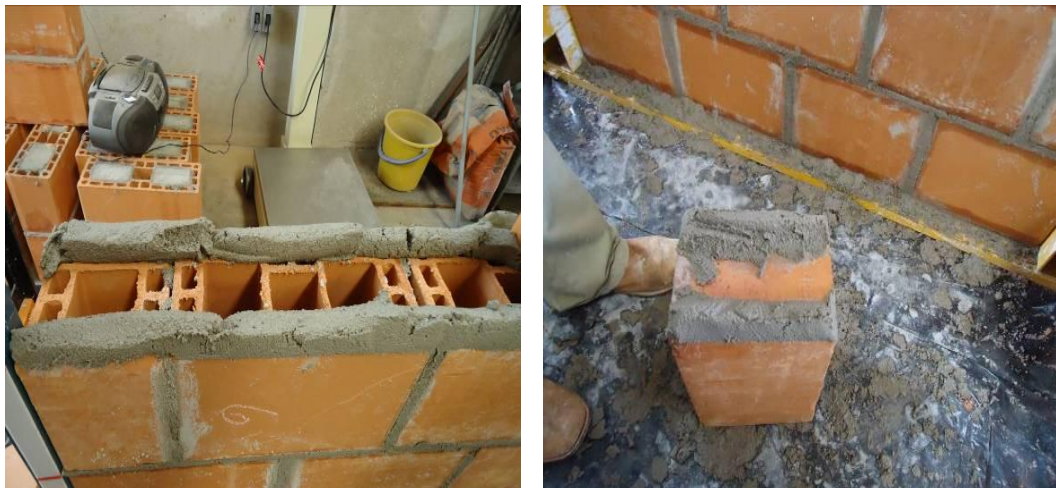
Figura 22 - Preenchimento das juntas horizontais e verticais da parede
