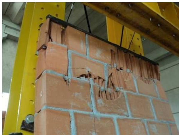
Figura 31 – Parede P1 após ruptura
