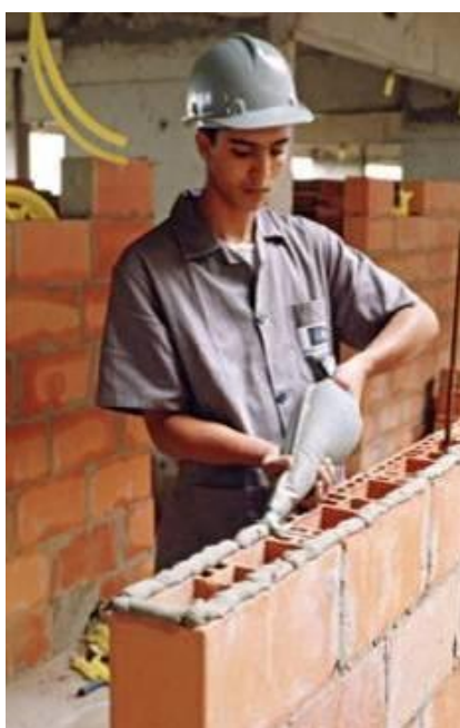
Figura 82 – Assentamento com bisnaga de confeitoiro
