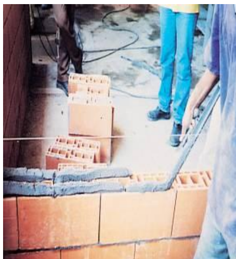
Figura 84 - Detalhe do filete de argamassa utilizando a colher meia-cana
