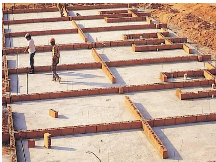
Figura 78 – Primeira fiada concluída
