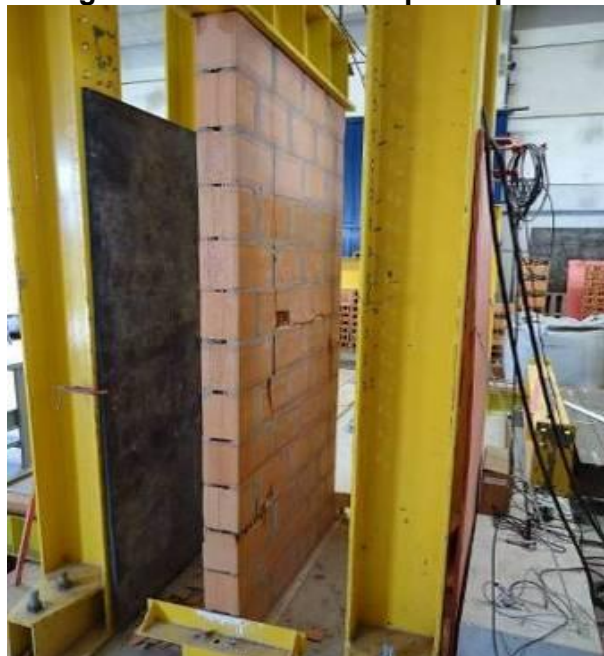
Figura 40 - Parede P7 – Após ruptura
