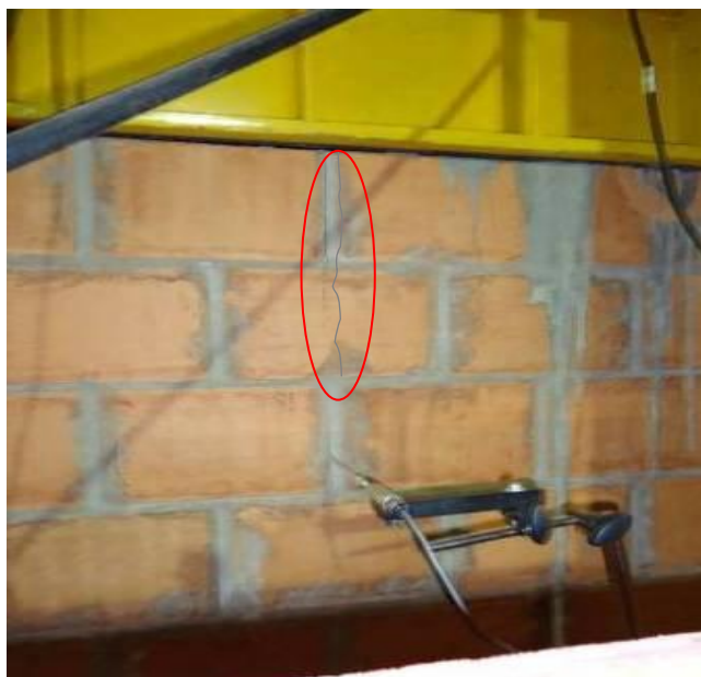
Figura 57 – Forma de ruptura da parede P10 (trinca vertical)
