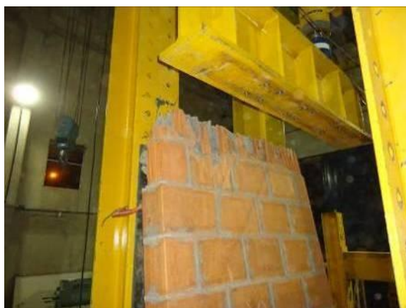
Figura 60 – Parede P11 após ruptura
