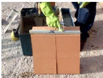
Figura 81 – Argamassa nas juntas verticais
