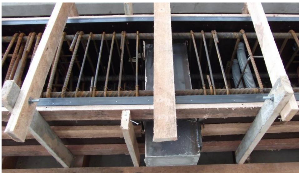
Figura 4.7: Tarugo metálico colocado na forma do pilar.
