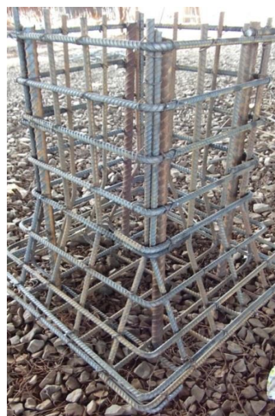
b) Armação do elemento de apoio
