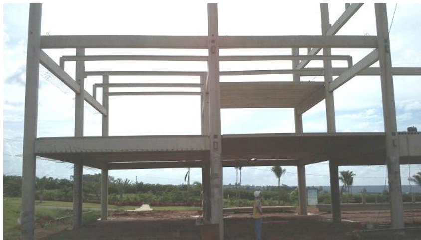
b) Montagem das vigas
