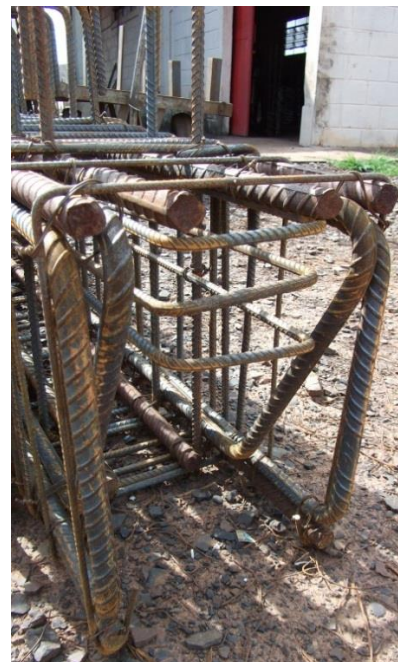
b) Armação da extremidade da viga
