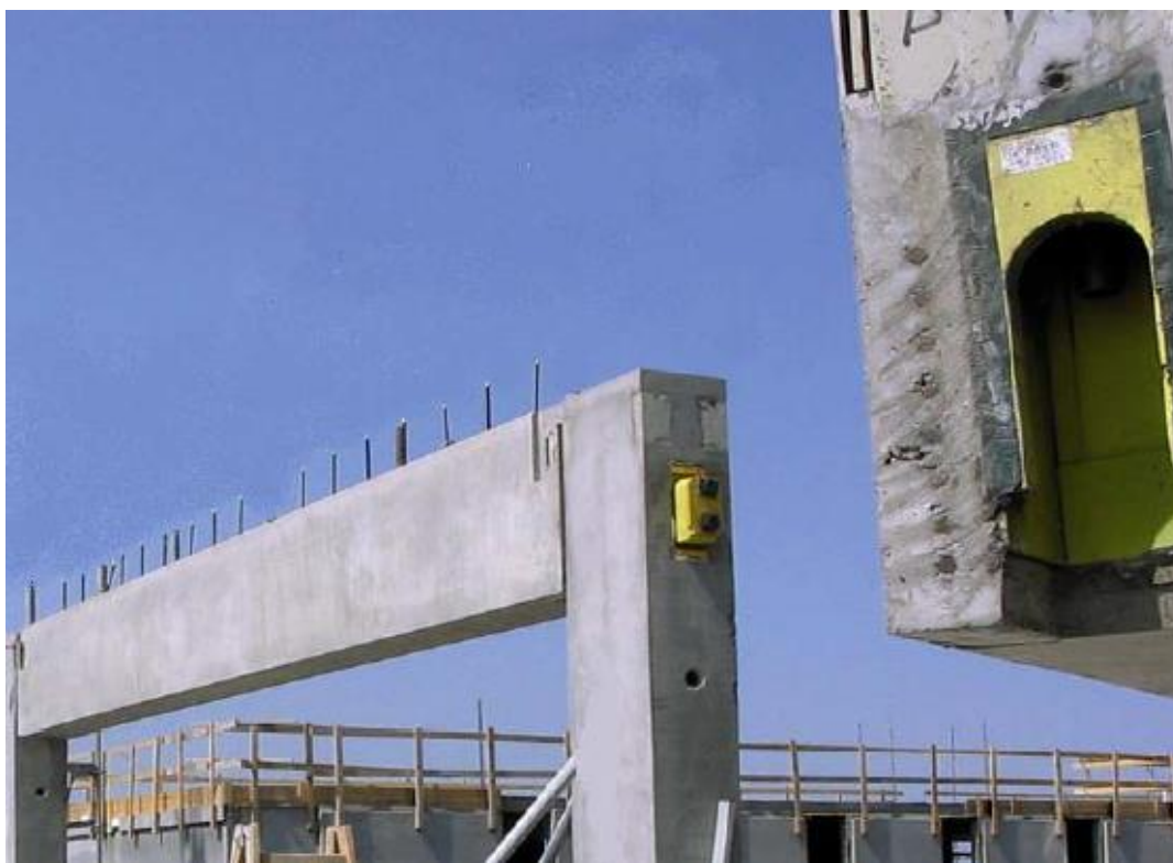
b) Aplicação em obra
