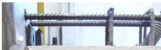
e) Colocação da armadura negativa
