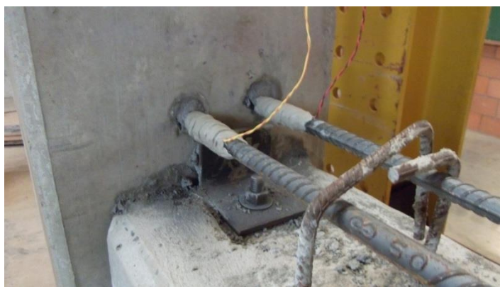
Figura 4.17: Extensômetros elétricos strain gages na armadura negativa.
