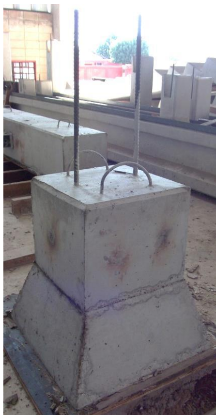
c) Elemento de apoio concretado
