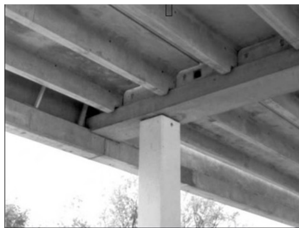
b) ligação viga-pilar de extremidade – Tipo II
