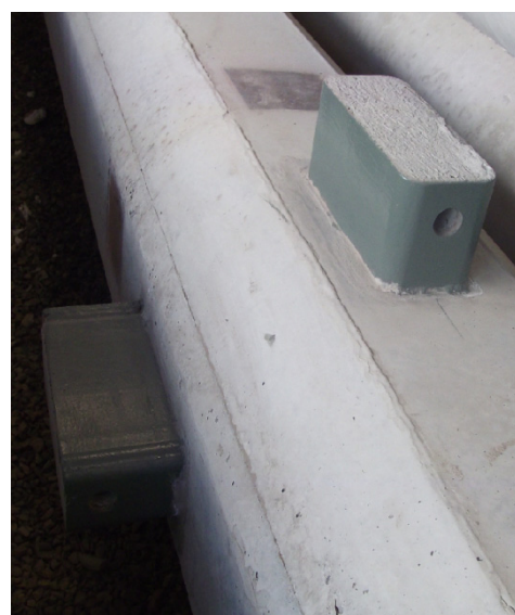
b) Grauteamento do perfil metálico
