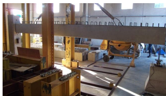
d) Montagem das vigas
