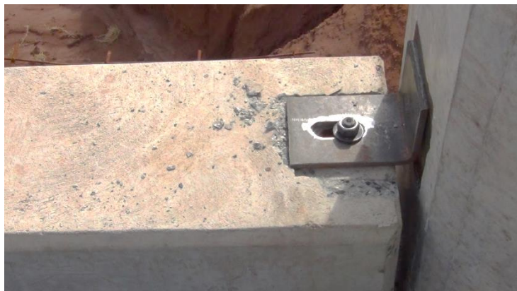
Figura 2.32: Estabilidade temporária da ligação por meio de cantoneira soldada ao pilar.
