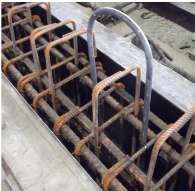
a) Pista de concretagem
