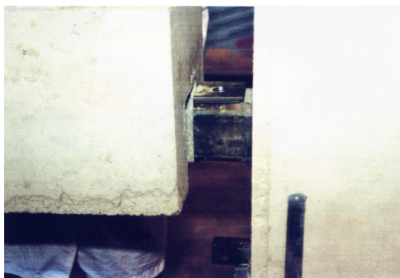
a) montagem da viga
