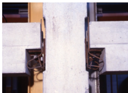
c) Viga montada
