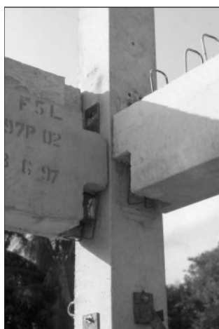
a) ligação viga-pilar de face - Tipo I
