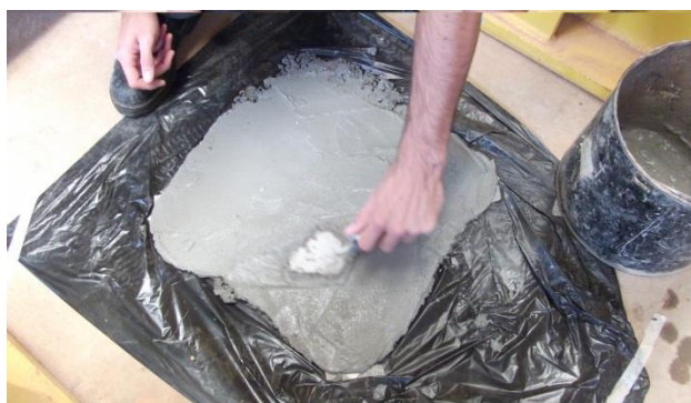
a) Argamassa de regularização
