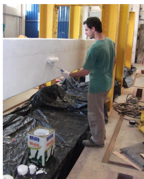
h) Pintura de vigas e pilar
