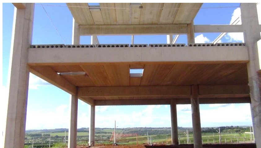
c) Viga solidarizada: ligação grauteada
