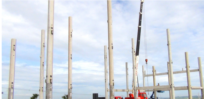
a) Montagem dos pilares
