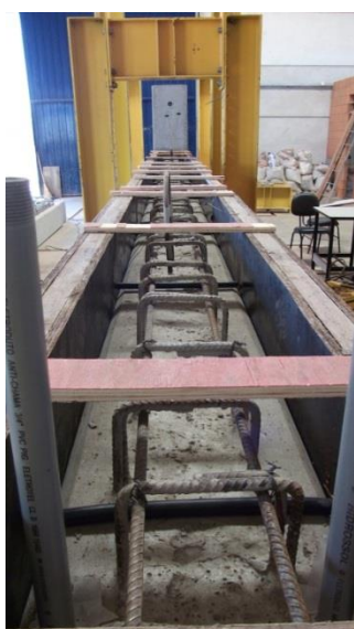
g) Concretagem da capa da viga
