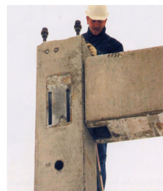
d) Viga montada
