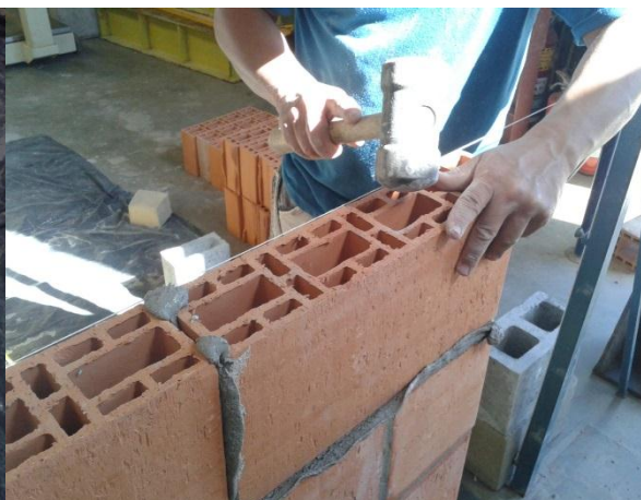
Figura 3-55: Utilização do martelo de borracha.
