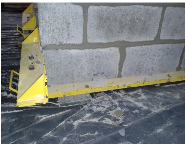
Figura 3-60: Abertura para retirada de argamassa de paredes grauteadas.
