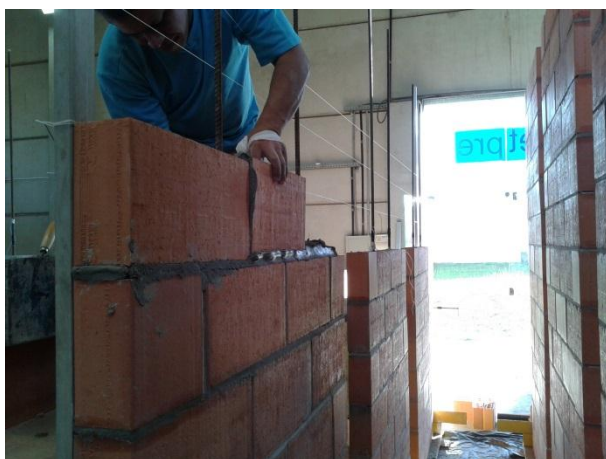
Figura 3-67: Assentamento de blocos 2ª etapa.
