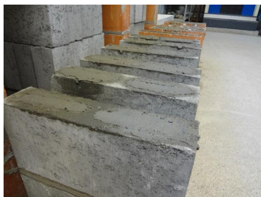
Figura 3-34: Grauteamento de prismas de concreto.
