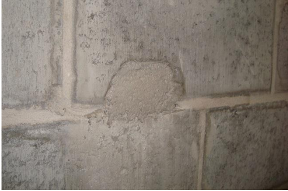
Figura 3-69: Abertura de retirada de argamassa em parede com blocos de concreto.
