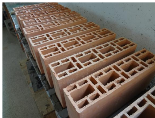
Figura 3-25: Capeamento blocos cerâmicos.
