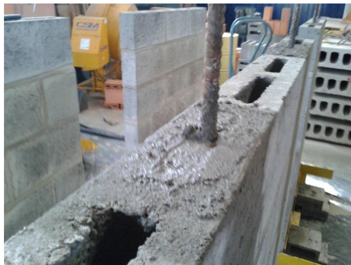
Figura 3-64: Grauteamento até a sétima fiada.
