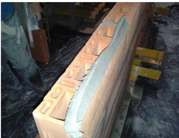
Figura 3-54: Cordão de argamassa.
