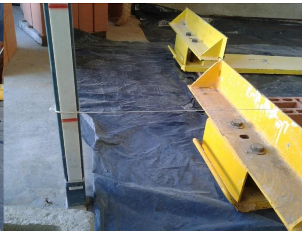
Figura 3-51: Detalhe do escantilhão.
