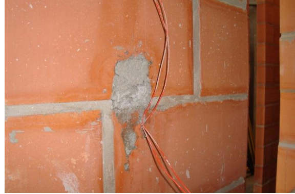
Figura 3-70: Abertura de retirada de argamassa em parede com blocos cerâmicos.
