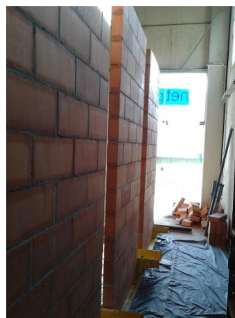
Figura 3-68: Paredes de blocos cerâmicos pronta.
