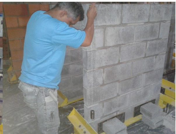
Figura 3-59: Verificação do prumo.
