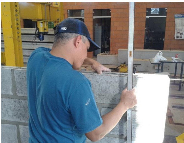
Figura 3-58: verificação de nível.
