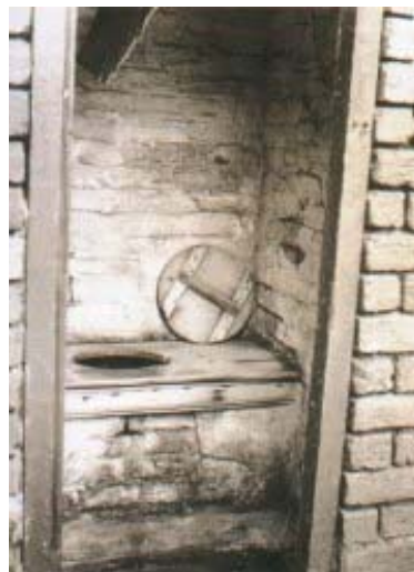
Figura 2.1: Latrinas externas ao edifício (PLUMBING SUPPLY, 2003a).
