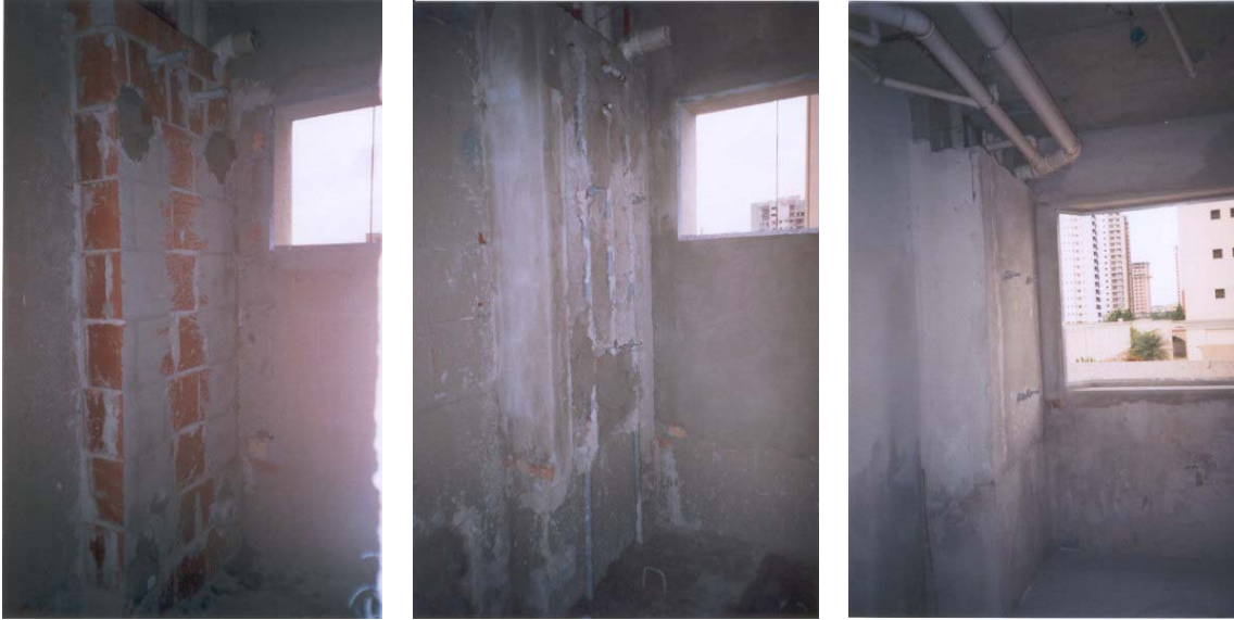
Figura 6.4: Instalação dos “kits hidráulicos”
