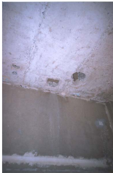
Figura 6.1: Furos nas lajes para passagem da tubulação
