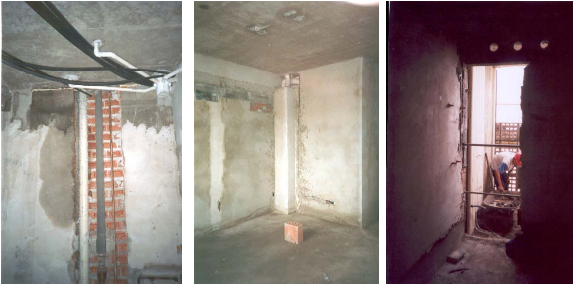
Figura 6.6: Shafts para tubulação vertical
