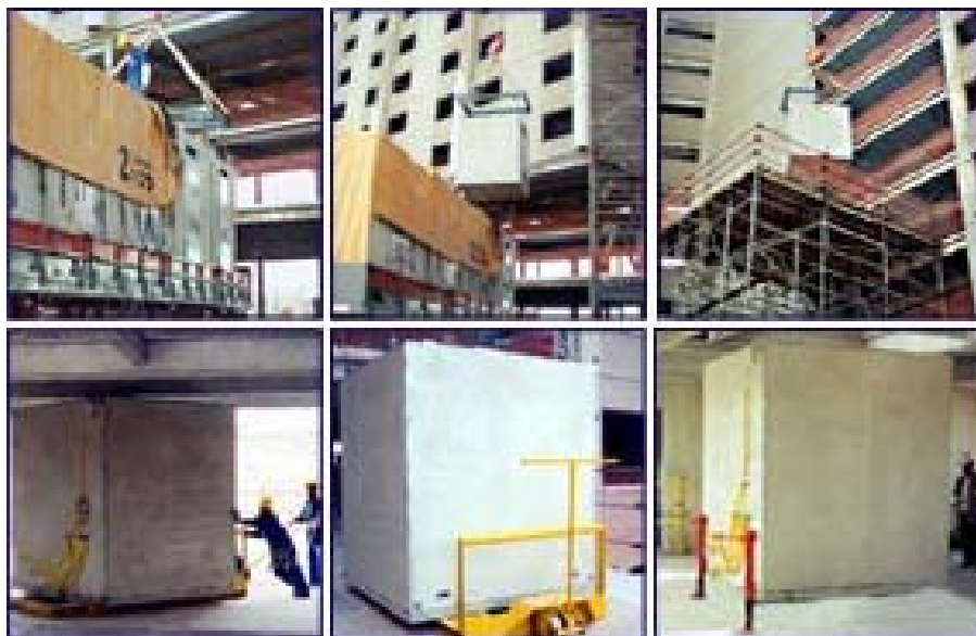
Figura 5.8: Lançamento com guias e plataformas (RIVOLI, op. cit. ).
