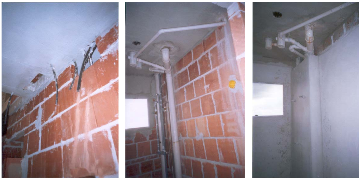
Figura 6.10: Detalhe dos shafts
