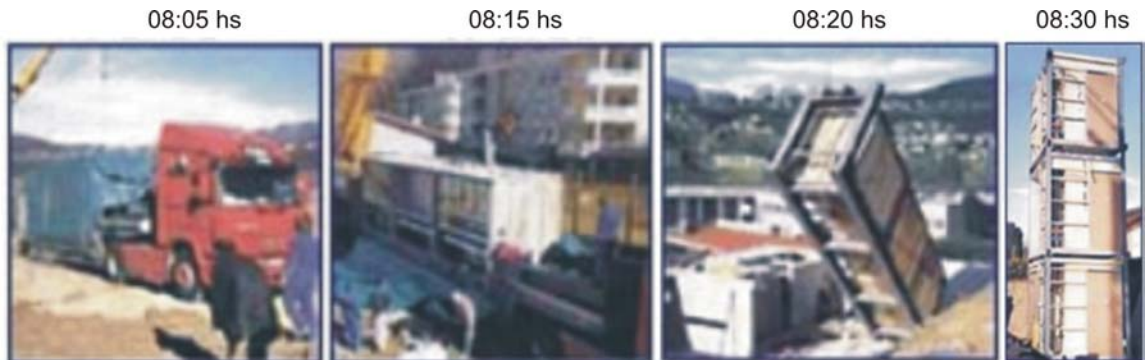
Figura 5.10: Montagem das torres de banheiros (RIVOLI, 2003).
