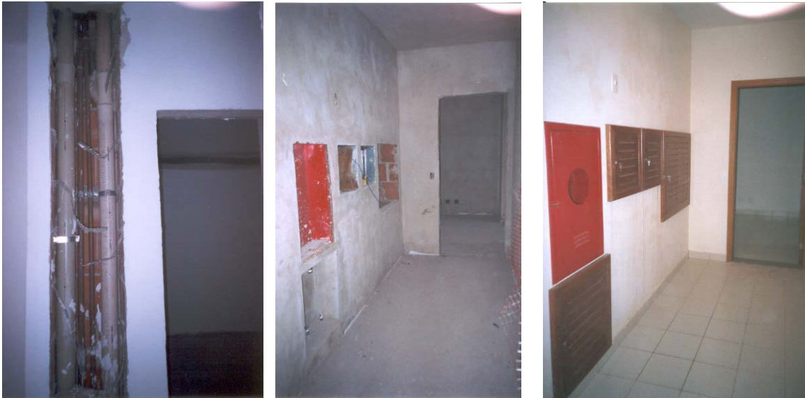
Figura 6.2: Shafts dos tubos verticais
