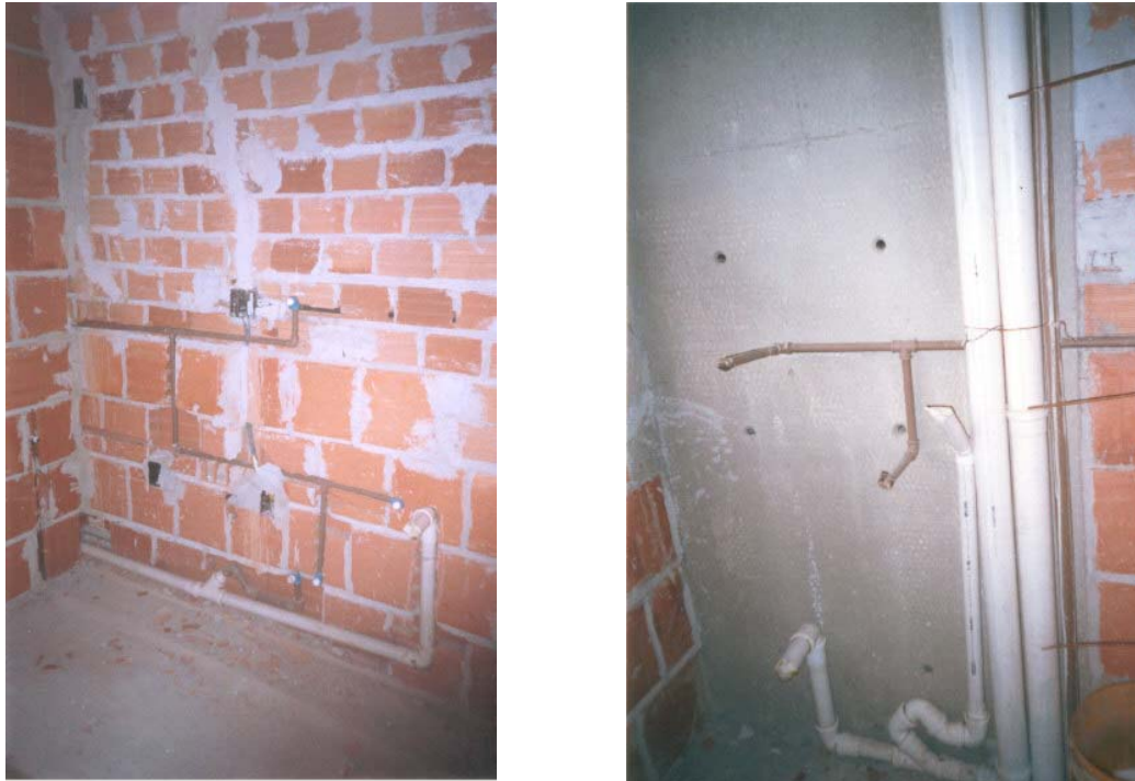
Figura 6.11: Detalhes da instalação dos ramais
