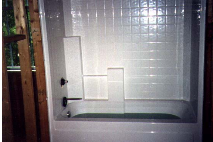
Figura 5.11: Banheira pré-fabricada (Arquivo pessoal, 2002).
