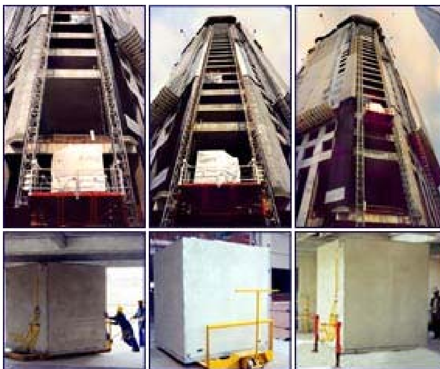
Figura 5.9: Lançamento com elevador externo (RIVOLI, op. cit. ).
