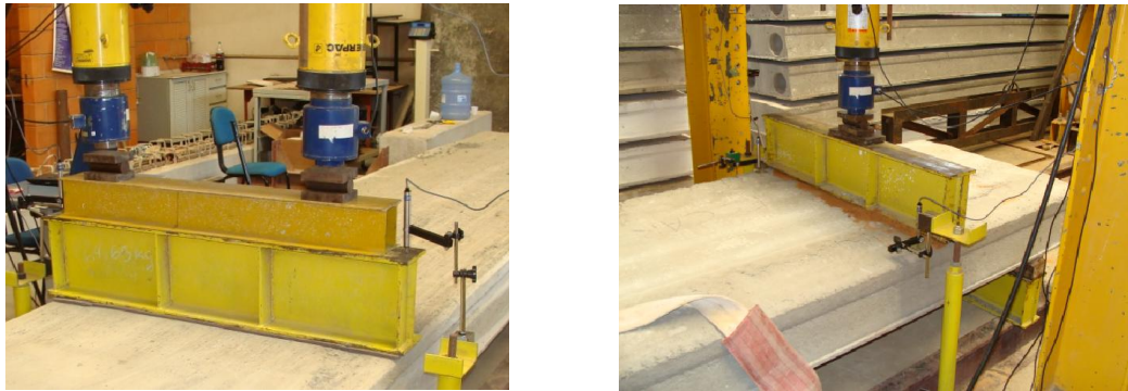
Figura 6.5: Vigas de transmissão, rótulas e chapas metálicas posicionadas
