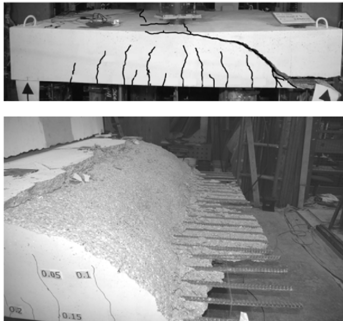
Figura 2.4: Fissura crítica de flexo-cortante
