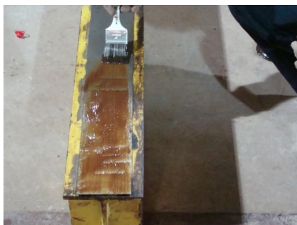
Figura 6.2: Preparação do apoio para a lajes
