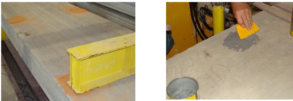
Figura 6.4: Regularização da superfície das lajes na região de contato com a viga de transmissão
