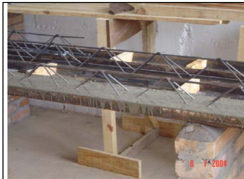
Fotografia 5.3. Forma para execução da sapata
