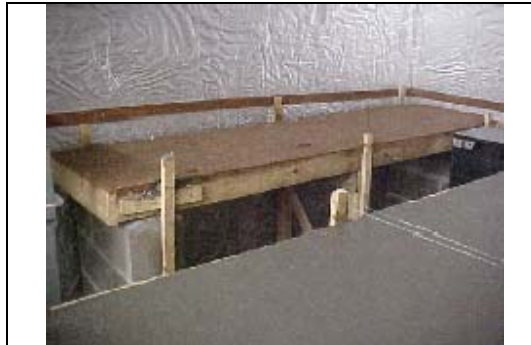
Fotografia 5.5. Cura das lajes (segundo plano) - areia molhada com água duas vezes ao dia
